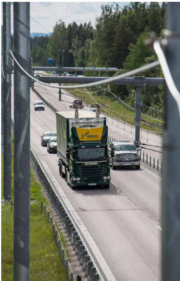
Bild från Trafikverkets demonstrationsprojekt i Sandviken med luftledning för eldriven godstransport.
