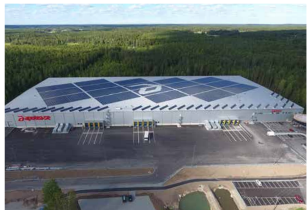
Apotea, i Morgongåva har Sveriges största solcellsanläggning på ett tak, invigd 2018, bild från Dagens Infrastruktur.
