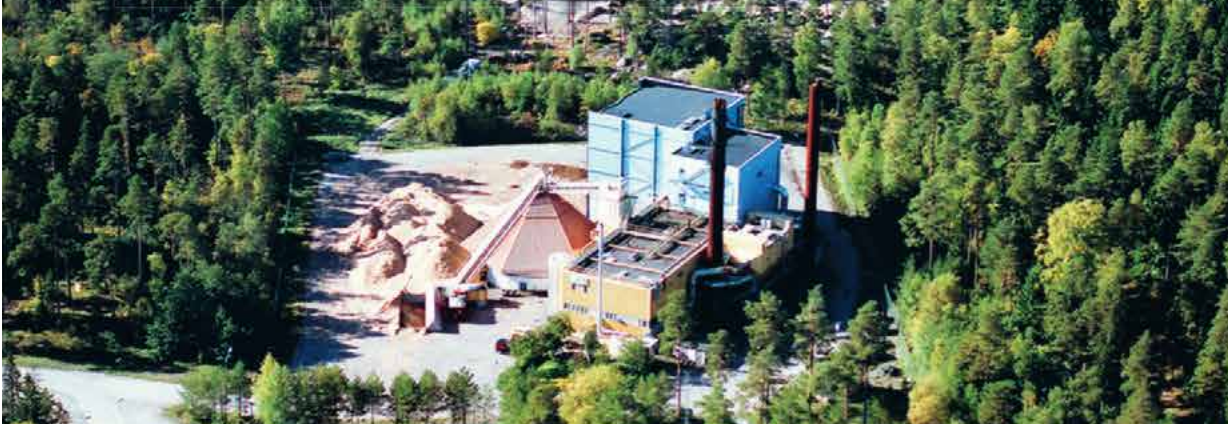
Fjärrvärmeverket i Knivsta, bild från Vattenfall Värme.
