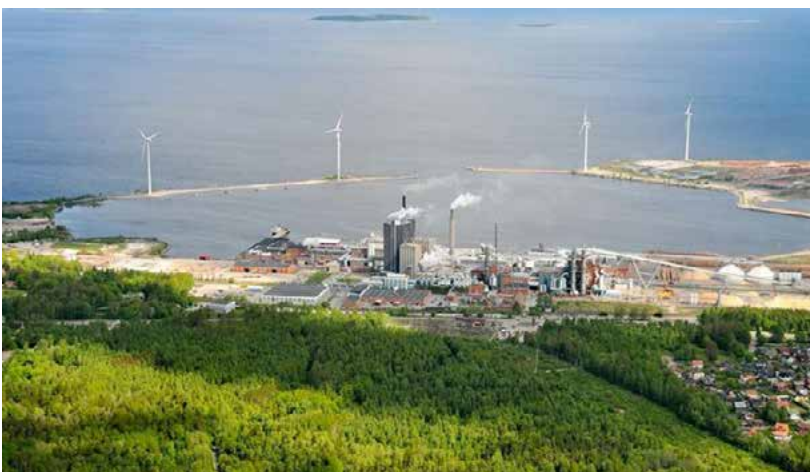
Skutskärs bruk, bild från Stora Enso AB. Massaproduktionen på Skutskärs Bruk är numera fossilfri till cirka 99 %. Som en biprodukt från massa-tillverkningen produceras tallolja som kan användas i olika produkter som tvättmedel och biodrivmedel. Talloljan utvanns för första gången 1899 i Skutskär och har internationellt behållit sitt svenska namn - exempelvis som tall oil (engelska), huile de tall (franska) och tallöl (tyska).
