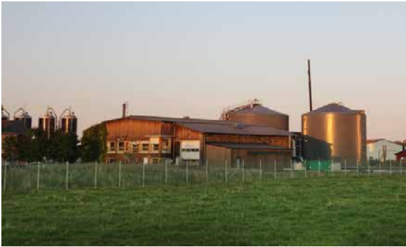
Biogasanläggningen i Uppsala, bild från Uppsala Vatten och Avfall.
