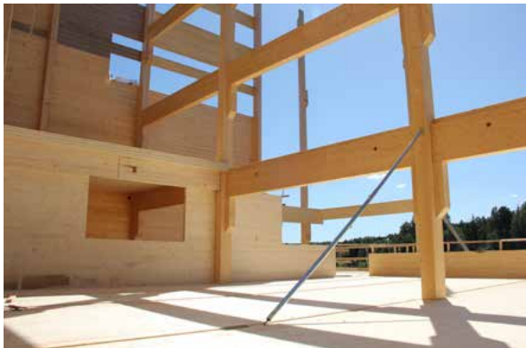
Bild från Knivstas nya Centrum för Idrott och kultur som byggs med trästommar vilket ger en lägre klimatpåverkan än betong.
