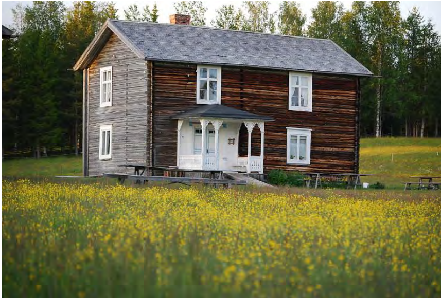
Figur 39. Byggnad på Rismyrliden (Rismyrlidens vänner okänt år)
