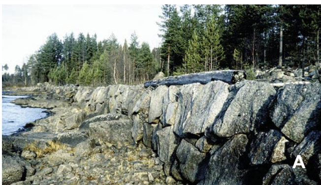
BILD 18. Stenbom. Djupseleforsen, Vindelälven. A. Vid lågvatten. B. Vid hög vattenföring. Foto: A: Erik Törnlund (1998). B: (2004).
