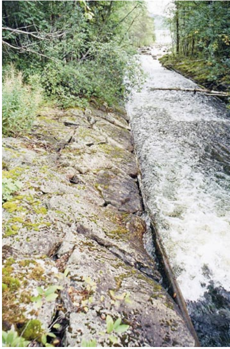
BILD 13. Skibord. Arvån, Vindelälven. Till vänster: Parallella stockar utlagda efter botten. Till höger: Stenslänt och rensad sten upplagd vid strandkanten. Foto: Erik Törnlund (2003).
