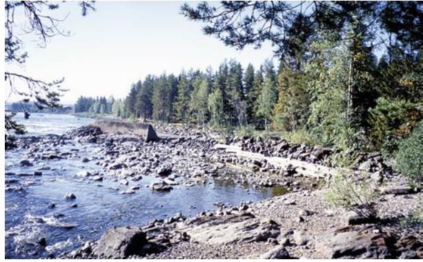
BILD 23. Styrskärm av helgjuten betong, Renforsen, Vindelälven. A: Vid vårflod. B: Vid lågvatten (sensommar). Framför styrskärmen syns en dubbel tråkista. Foto: A-B: Erik Törnlund (2000).
