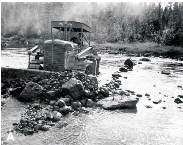
BILD 4. Stenrensning. A. Traktor i arbete, Vormbäcken, Vindelälven (1948) B. Rensning med stubbrytare efter ett bivattendrag. Bilden troligen från 1940- eller 50-talet, men visar lika mycket på ett förhållande som rådde vid sekelskiftet 1900. Plats okänd. Källa: Umeå flottningsförenings arkiv, Folkkrörelsearkivet, Umeå.
