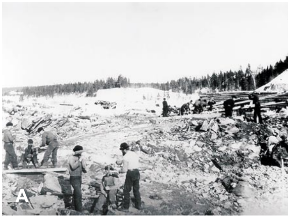
BILD 21. Flottledsbyggande. A: Sprängningsarbeten och uppförande av dubbel trækista. Renforsen, Vindelälven, vid början på 1900-talet. B: Kranarbete, Umeälven, under 1930-talet. Källa: A: Degerfors byamäns arkiv, Vindelns kommun. B: Umeå flottningsförenings arkiv, Folkrorelsearkivet, Umeå.
