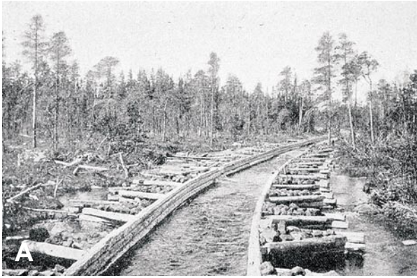
BILD 6A. A: Enkel träkista. Observera den kanaliseringseffekten av konstruktionerna; det ursprungliga vattendragets bredd syns på sidorna. B: Dubbel träkista. Fotot taget vid Ruskträskbäcken år 1928. Konstruktionen skadad efter kraftigare vårflöde. Foto: A: Löf, A., Kinnman, G (1922). "Flottning och annan vattentransport av oförädlat virke", Handbok i Skogsteknologi. Stockholm. B: Umeå flottningsförenings arkiv, Folkrorelsearkivet, Umeå.
