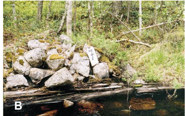
BILD 7. Spår av enkelkistor. A. Arvån, Vindelälven. B. Dito, foto av det som återstår av trekantkar (troligen uppförd vid sekelskiftet 1900). Foto: Erik Törnlund (2003).
