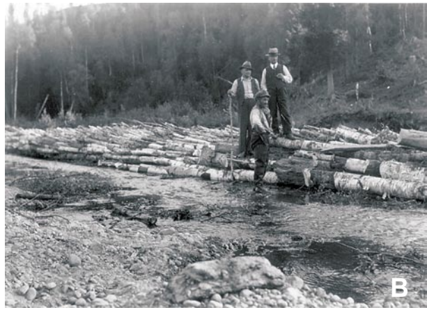
BILD 10. A. Riskista i genomskärning. Här försedd med pålar för ökad hållfasthet. B. Uppförande av risarm för strandskoning, bivattendrag till Öre älv under 1930-talet. Pil visar strömriktning. Observera att byggnadsmaterialet består av relativt grovt björkmaterial. Detta träslag hade relativt lågt marknadsvärde och lämpade sig därför väl för sådana här konstruktioner. Problemet var dock att björkvirket förmultnade ganska snabbt jämfört med det av tall. Källa: A: Kinnman, G (1917). "Om flottleder och flottning I", Norrlands Skogsvårdsförbunds Tidskrift. B: Umeå flottningssällskapets arkiv, Folkhälsohistoriska arkivet, Umeå.
