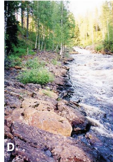
BILD 12. Stenslänt. A. Arvån, Vindelälven. Stenslänten är lagd i glacis, uppfördes år 1933/34. Tidigare låg här en stöttbotten utefter vattendraget. B. Arvån, Vindelälven. Denna stenslänt stänger av en ursprunglig strömföra och är här placerad ovan grävd kanal (ny sträckning av vattendraget, 1933/34) C. Gargån, Vindelälven, numera utrivnen. D. Sävarån (Krokforsen). Foto: A-B: Erik Törnlund (2003). C: Niclas Hjerdt (2003). D: Erik Törnlund (1999).
