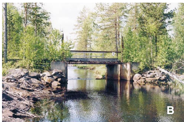
BILD 2. A. Luckdamm, Långhjuksnorsdammen, Hjuksån. Del av landarmens framsida och slussväggarna är beklädda med kilad sten. Till vänster, framför dammen, syns en ledbom (fyra stockar bred). Den användes för att styra virket rätt och att stå på för flottningsarbetarna när timret matades in genom slussen. B. Bjälksättsdamm, Bredträskådamm, Hjuksån. Denna typ av dammkonstruktion började uppföras under 1930-talet och framåt. Betongplattor används för att göra slussväggar och överbyggnad mer stabila. Foto: Erik Törnlund (2003).
