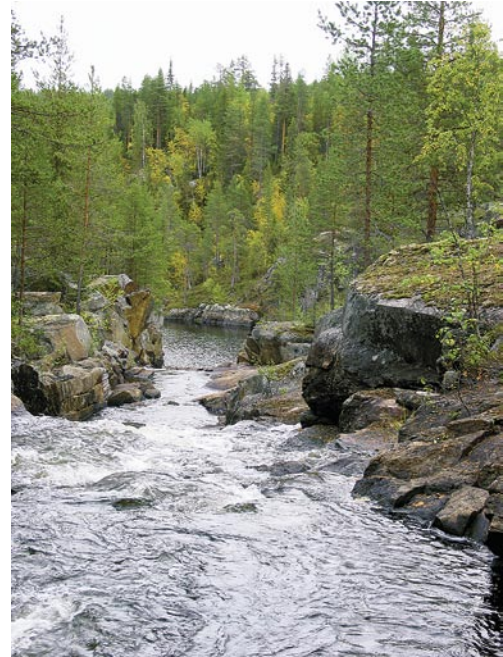
BILD 15. Kanalisering genom sprängning. Rågobäcken, Vindelälven. Kanal genom och över berget vid Hällträsket. Tidigare fanns här en timmerränna. Kanaliseringen utfördes vid mitten av 1940-talet. Foto: Erik Törnlund (2000).
