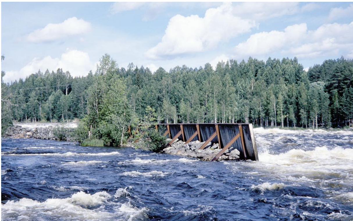
BILD 22. Styrskärm av betongplattor. Renforsen, Vindelälven. Foto: Erik Törnlund (2000).
