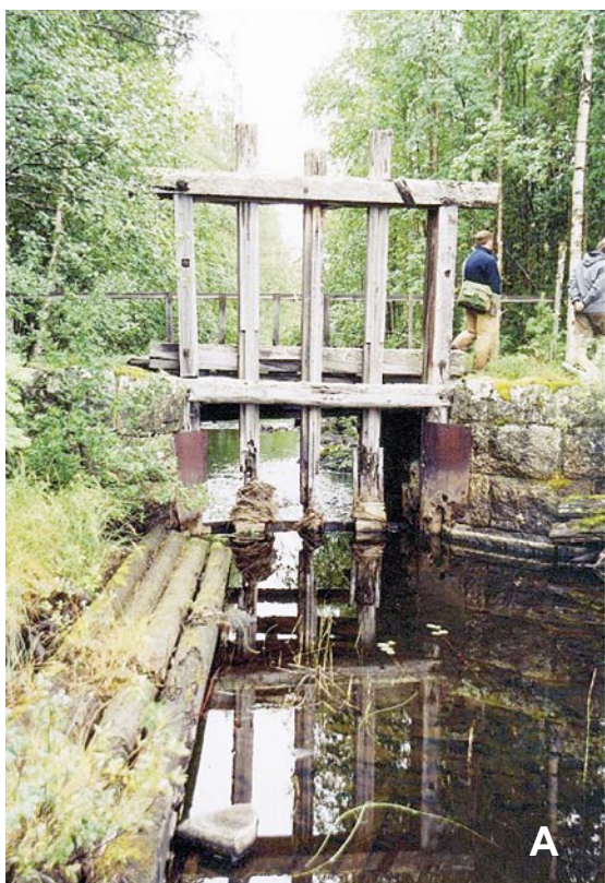
BILD 2. A. Luckdamm, Långhjuksnorsdammen, Hjuksån. Del av landarmens framsida och slussväggarna är beklädda med kilad sten. Till vänster, framför dammen, syns en ledbom (fyra stockar bred). Den användes för att styra virket rätt och att stå på för flottningsarbetarna när timret matades in genom slussen. B. Bjälksättsdamm, Bredträskådamm, Hjuksån. Denna typ av dammkonstruktion började uppföras under 1930-talet och framåt. Betongplattor används för att göra slussväggar och överbyggnad mer stabila. Foto: Erik Törnlund (2003).
