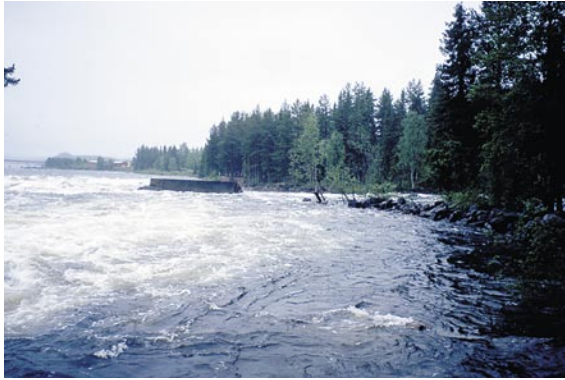
BILD 23. Styrskärm av helgjuten betong, Renforsen, Vindelälven. A: Vid vårflod. B: Vid lågvatten (sensommar). Framför styrskärmen syns en dubbel tråkista. Foto: A-B: Erik Törnlund (2000).
