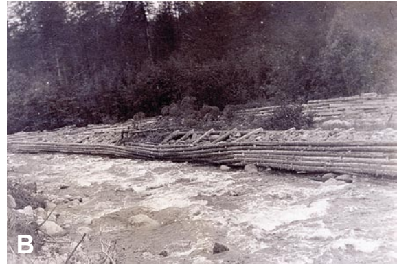
BILD 6A. A: Enkel träkista. Observera den kanaliseringseffekten av konstruktionerna; det ursprungliga vattendragets bredd syns på sidorna. B: Dubbel träkista. Fotot taget vid Ruskträskbäcken år 1928. Konstruktionen skadad efter kraftigare vårflöde. Foto: A: Löf, A., Kinnman, G (1922). "Flottning och annan vattentransport av oförädlat virke", Handbok i Skogsteknologi. Stockholm. B: Umeå flottningsförenings arkiv, Folkrorelsearkivet, Umeå.
