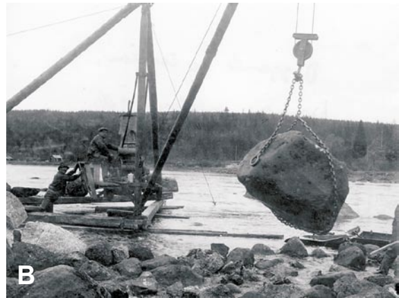
BILD 21. Flottledsbyggande. A: Sprängningsarbeten och uppförande av dubbel trækista. Renforsen, Vindelälven, vid början på 1900-talet. B: Kranarbete, Umeälven, under 1930-talet. Källa: A: Degerfors byamäns arkiv, Vindelns kommun. B: Umeå flottningsförenings arkiv, Folkrorelsearkivet, Umeå.
