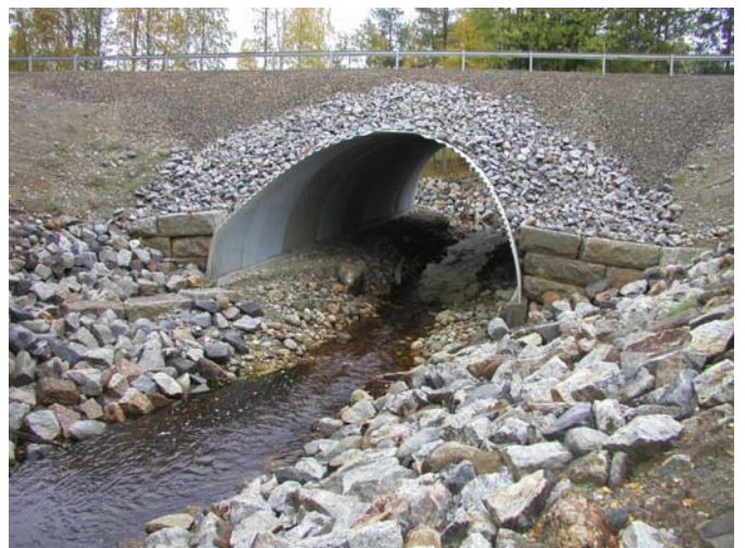
Under 2006 ersattes trummorna i Malbäcken med en valvbåge av galvaniserat stål med en diameter på 6,5 meter.
