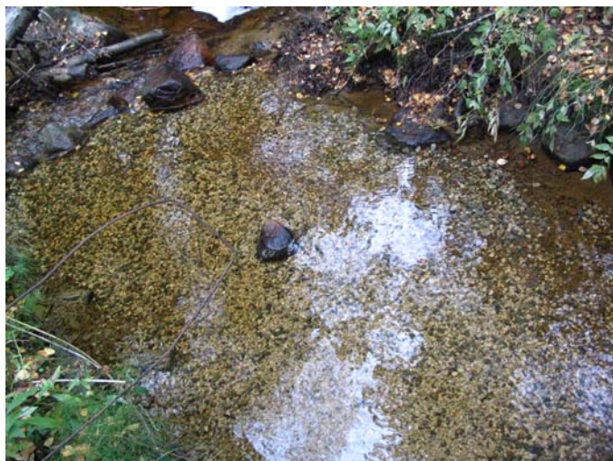
Konstruerad lekbottnen i Ilbäcken bestående av naturgrus och kalkgrus. Foto: Daniel Palm.
