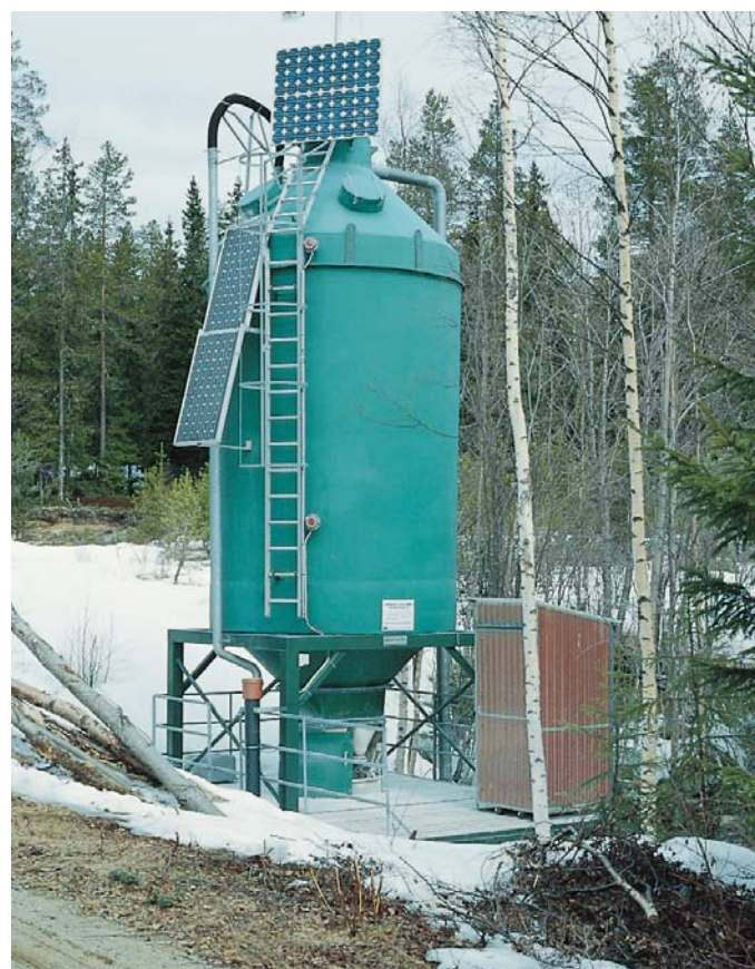
Kalkdoseraren i Stridbäcken hade från början enkel teknik och saknade bland annat flödesberoende reglering av kalkutmatningen.
