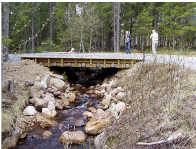
Bro av limträ som vilar på fundament av prefabricerade betongbalkar.
