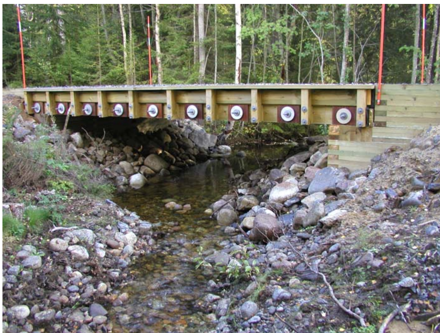
Ny bro i Vinan. Brospann av limträ och fundament av timrade stenkistor.
