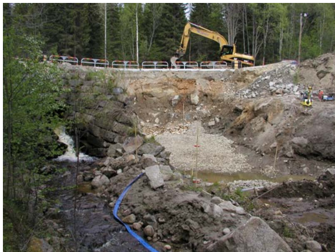
Anläggning av valvbåge i Stockbäcken. Läget för valvbågen är något förskjutet i förhållande till befintlig trumma.
