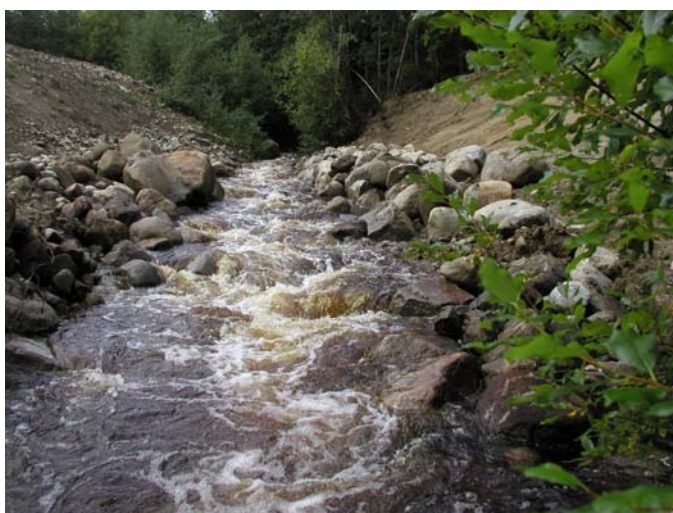
Vägbanken har grävts bort och Sågbäcken har återställts.
