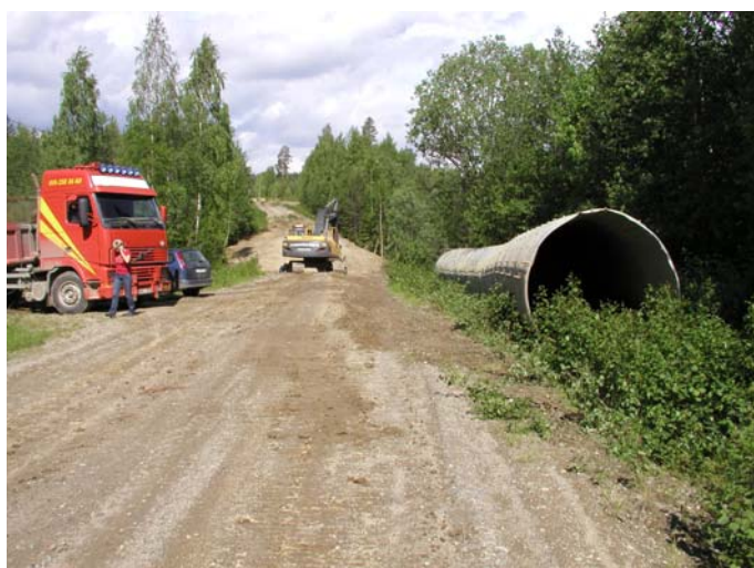
Vägtrumma i Sågbäcken som avlägsnades genom att en ny vägsträckning anlades som inte korsade bäcken.
