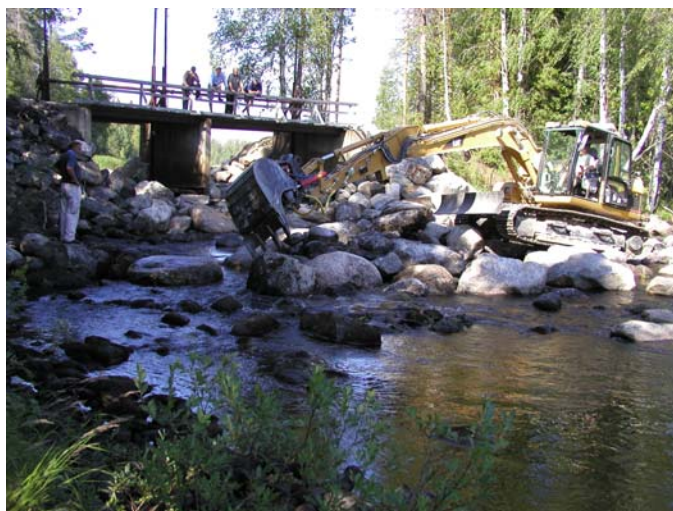
Överfallströskel som anlagts som ersättning för träskättar. Tröskelns ovansida justeras för att underlätta fiskvandring vid lågflöde.
