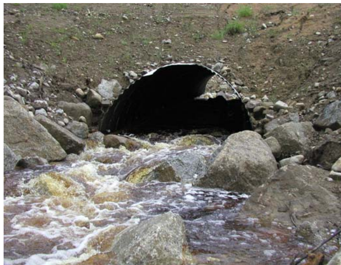
Ny valvbåge av galvaniserad plåt på plats i Stockbäcken.
