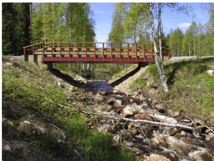
Bro av limträ som vilar på fundament av timrade stenkistor.
