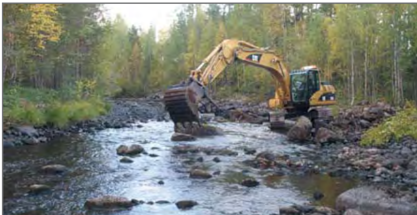
Restaureringsarbete i Manjaurån, Vindelns kommun. Foto: Roger Vallin
