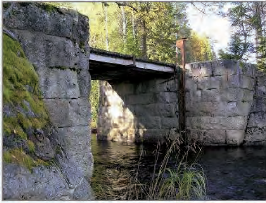
BILD 2. Tidigare flottningsdamm, Fäboträskdammet, numera utriven med undantag för utskovet som består av vällagd kilsten. Tjänar idag som vägbro. Rödån, bivattendrag till Vindelälven, vid utloppet av Fäbodträsket.
