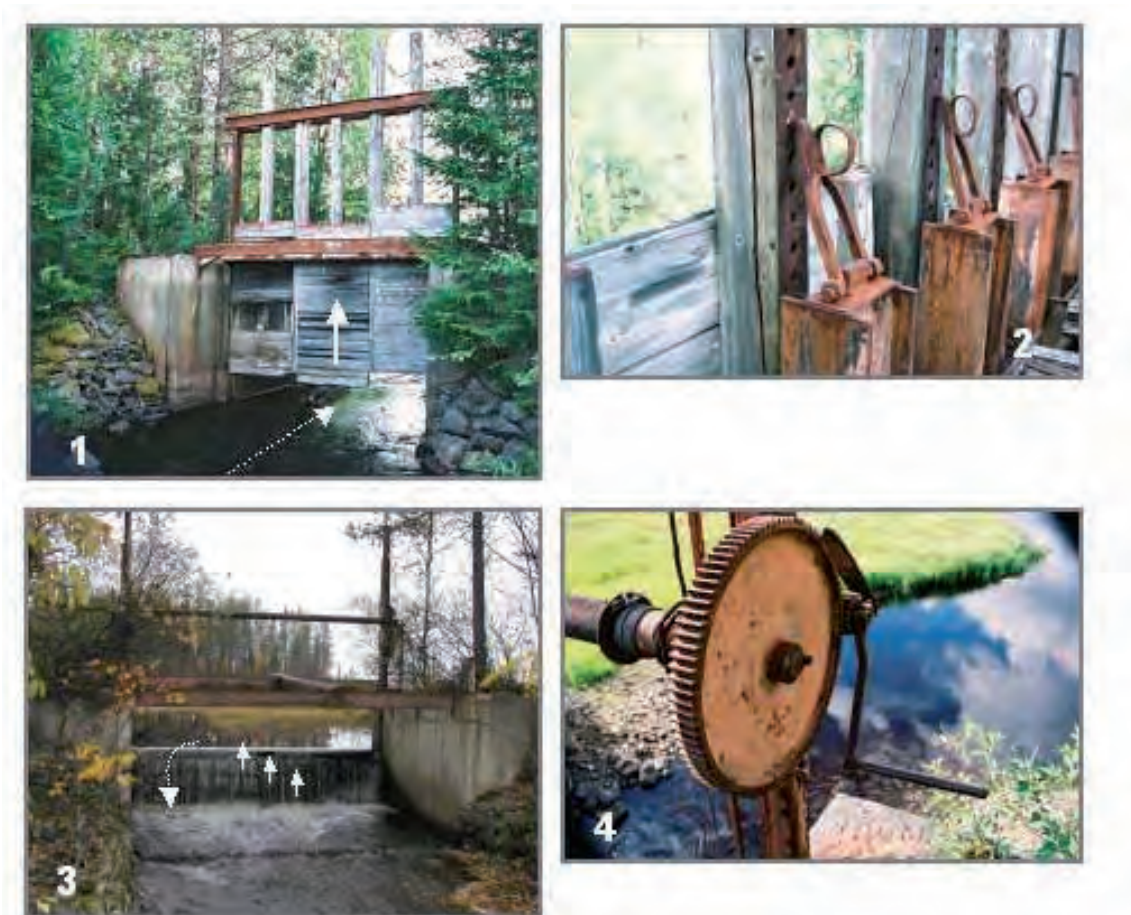
BILD 12. Principer för dämning med luckdamm (1) respektive bjälksättsdamm (3). Luckdämnet justerades i höjled genom att bända luckstolpen med hjälp av spett. Luckstolpen låstes sedan önskad position med järnbygel (2). Bjälkdämnet justerades med hjälp av speplanordning (4).
