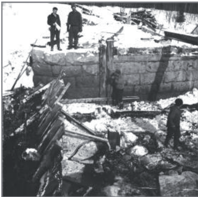
BILD 11. Reparation av Pauträskdammen (nr 374), Paubäcken, Umeälven. Vårvintern 1952.
