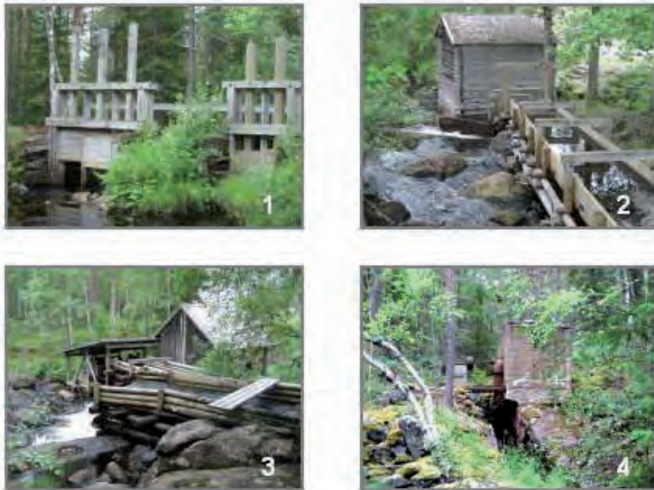
BILD 4. Kulturmiljön vid Baksjöleden, Mellansjöbäcken, ett bivattendrag till Lögdeälven. Ett bra exempel på hur olika vattenkraftsrelaterade verksamheter placerats i anslutning till en gemensam damm (1): skvaltkvarn med tillhörande ränna (2), något nedströms en spånhyvel (3) samt rester av elkraftverk (4). Tidigare låg här även en vattensåg, strax nedan spånhyveln.
