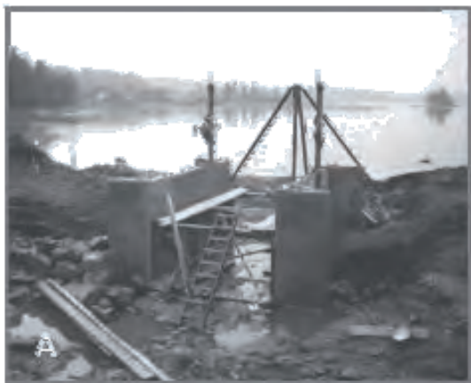
Bild 10. Uppförande av flottningsdamm, Lillarmsjödammen, Hörnån (ID-nr304). A. Under uppförande, november 1949. B. Dammen färdig, april 1950. På bilden syns tydligt nylagt slussgolv, styrkistor och landarmar. C. Dammen idag.
