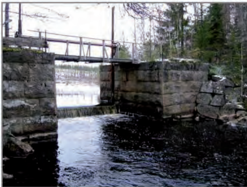
BILD 8. Flottningsdamm, väl uppförd av kilad och huggen sten. Beläggen ca 800 meter nedströms Stavarsjön, Gideälven (nr 139).
