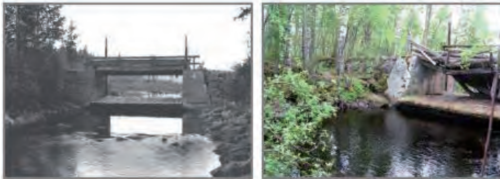
BILD 9. Exempel på flottningsdamm med utskov av helgjuten betong, Långviskadammen (nr 213), Holmsjöbäcken, bivattendrag till Lögdeälven. Dammen uppfördes i sitt befintliga skick 1934. Den vänstra bilden är från 1960 och den högra 47 år senare. Med undantag från brobanan som murknat och rasat är dammen för övrigt i mycket gott skick.
