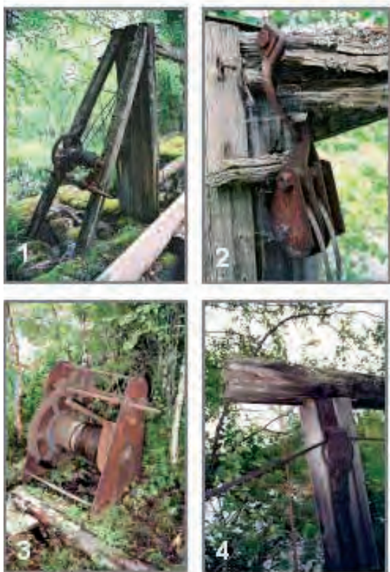
BILD 13. Få bevarade och mycket unika exempel på teknisk lösning vid justering av bjälkdämmen. Spelanordning vid sidan av stolparna, tillverkade av trä, med taljor genom vilka vajrar löper. Vajrarna är sedan fästa vid bjälkarna med hakar. Lillvalvattendammen (nr 161), Valvattenbäcken, Gideälven (1-2) respektive Strutendammen (nr 526), Hjuksån, Vindelälven (3-4).
