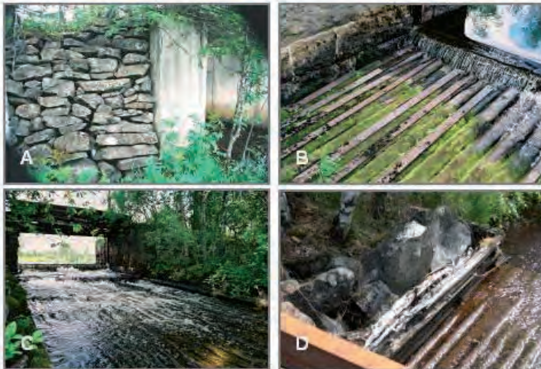
BILD 7 A-D. A. Landarmens anslutning till utskovet. B. Slussgolv, här förstärkt med järnbeslag. C. Slussgolv nedströms slussen. På ömse sidor av slussgolvet kan man skymta styrkistornas timring. D. Styrkista uppford av timrad vägg med stenfyllning. Foto: Erik Törnlund, 2007.
