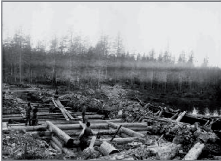
BILD 5. Uppförande av flottningsdamm. Blästtjärn, Kälkåns flottled, Dalarna. Fotograf är Hesselman, H. September 1903. Ovan byggarbetsplatsen har en temporär dammvägg satts upp för att förhindra vatten från sjön att rinna ner. Dammanläggningens utskov håller på att timras upp. En bana av plank har lagts ut för att underlätta tilltransport av fyllnadsmaterial med hjälp av tippkärr.
