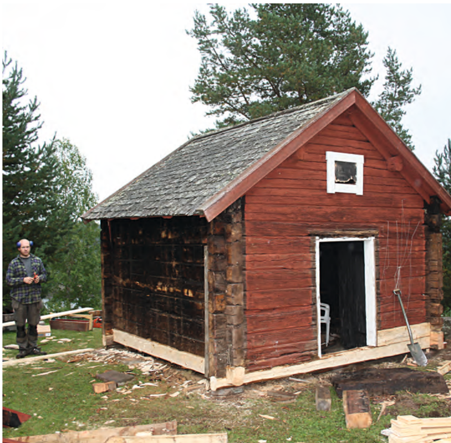
Rökhus under pågående arbete.
