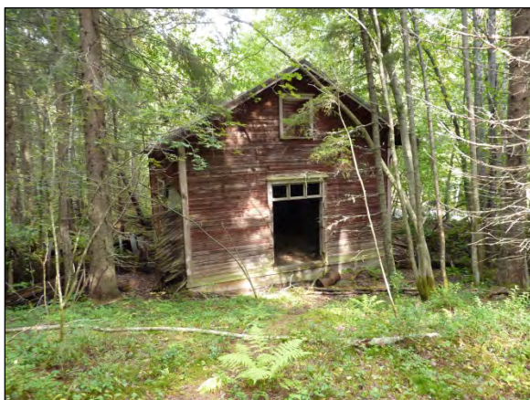
Kraftstation vid Leduforsen.
