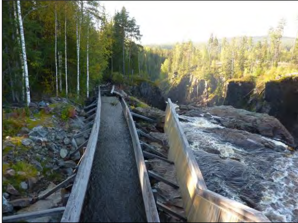
Rekonstruktion av timmerränna.
