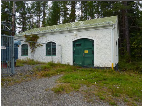
Fäbodbäckens nedre kraftstation.
