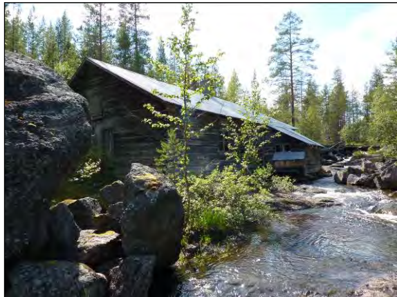
Bäcklidens gamla kraftstation.
