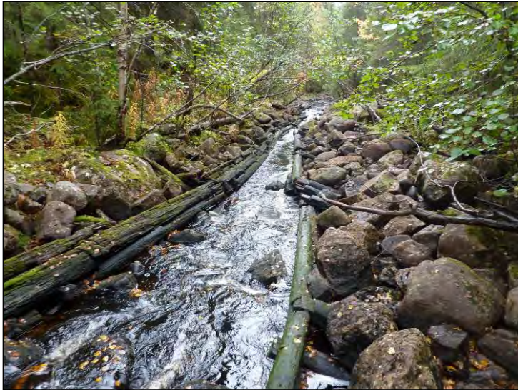
Enkelkistor på båda sidor om bäcken.
