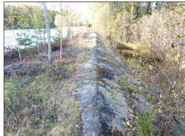
Släntmur av betong.
