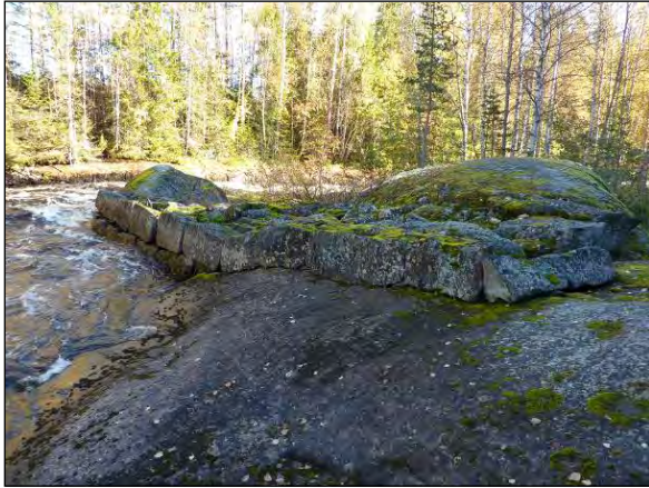
Kilstensmur delvis på berghäll.
