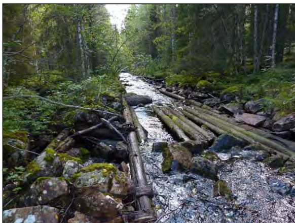
Dubbelkista-stötgolv, Västvattenbäcken.
