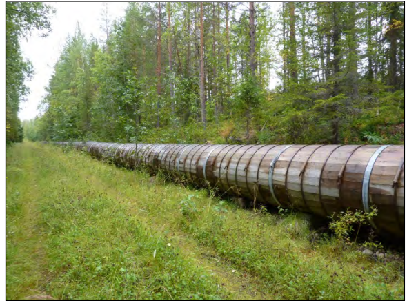
Trätub mellan damm och kraftstation.
