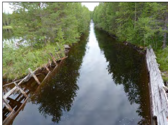
Kanal med styrskårmar.
