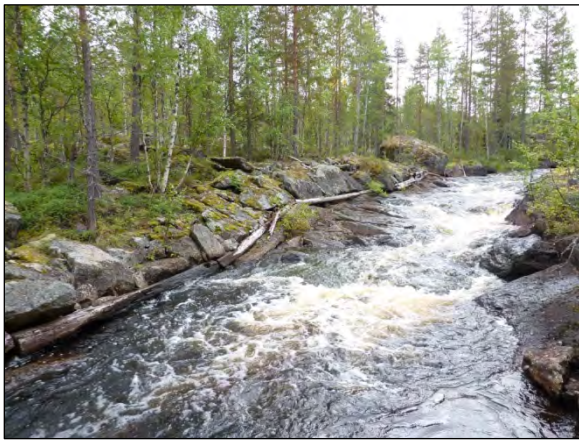
Släntmur med träförstärkning.
