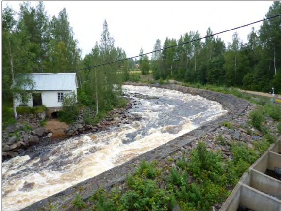
Kilstensmur och kraftstation
