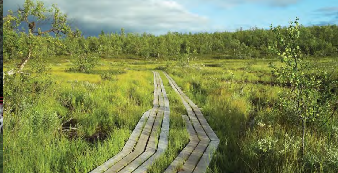
Markförstärkning i Vittangi sameby hösten 2013, där Länsstyrelsen Västerbotten administrerar ett projekt för att minska skador på känsliga våtmarker orsakade av terrängkörning. Foto: Vittangi sameby
