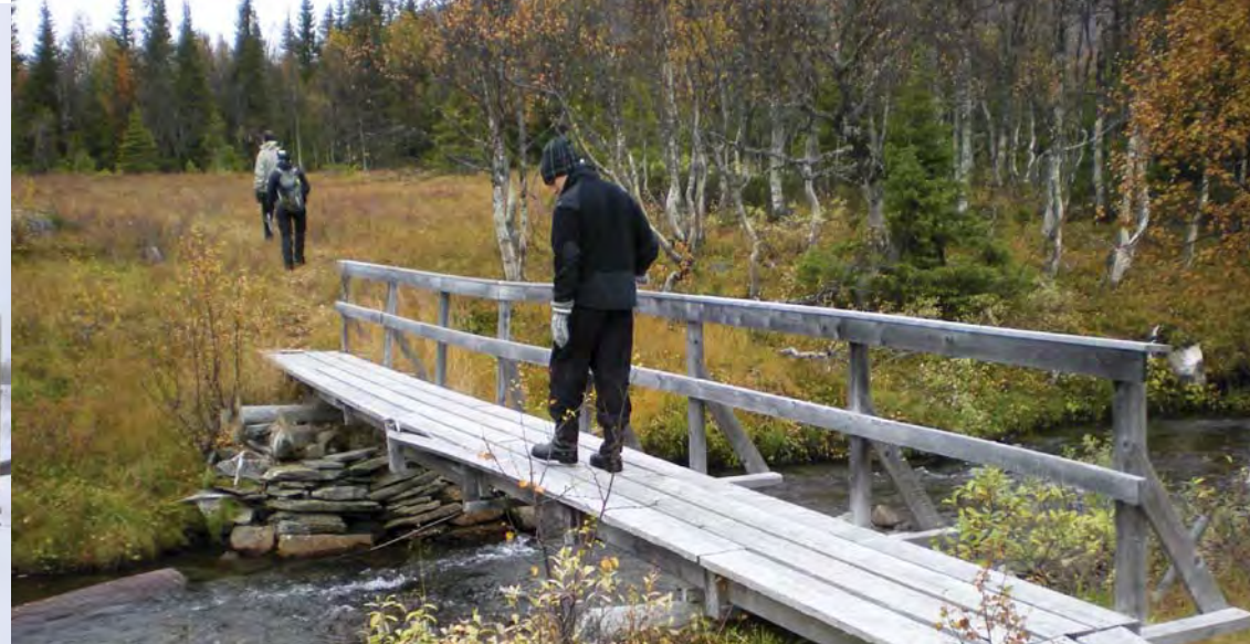
Bro i Borgafjäll. Broar och spänger i fjällen inspekteras och underhålls regelbundet. 2013 byttes 15 broar ut och några hundra meter spång byggdes. Foto: Lena Lundevaller
