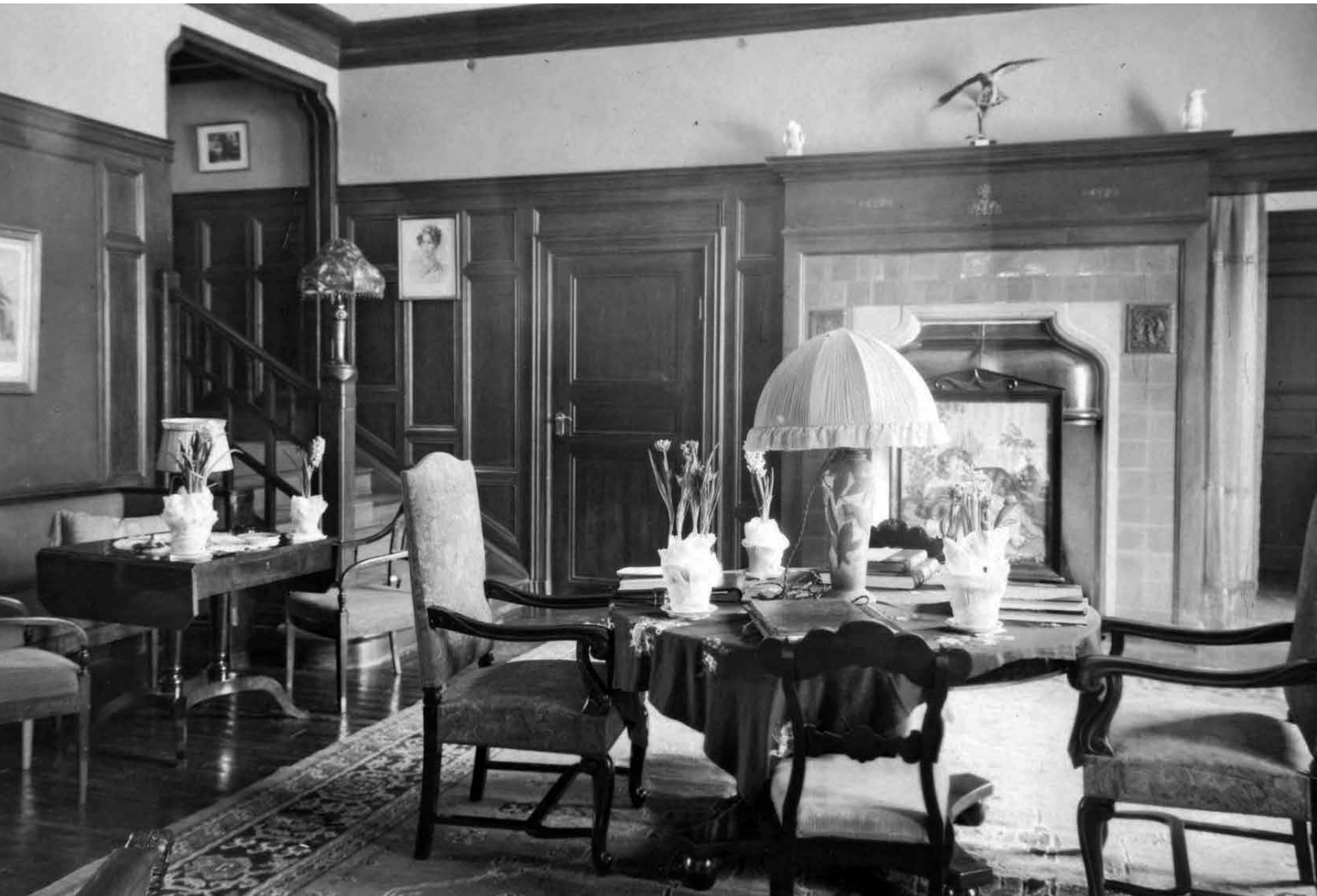
Nedre hallen vid samma tillfälle mot öster omkring 1920. På bilden syns den numera borttagna öppna spisen med sandstensornament, kakel- och kopparplåtsinklädnad. T.v. om spisen syns den dåvarande dörren till det bakomliggande kontorsrummet/herrns rum och omedelbart t.h. dörren till kapprummet. Foto hos Charlotte Unander-Scharin, Västerås.
