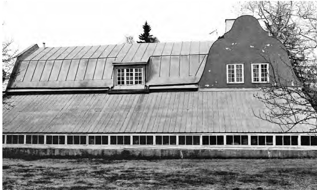
Växthuset vid uthusets södra fasad. Den övre glasade delen har vid denna tidpunkt täckts över med pannplåt. Foto omkring 1980 i Länsstyrelsens arkiv.
