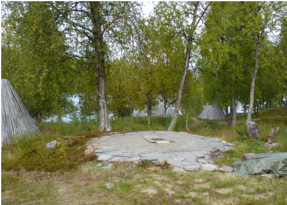
Grundläggning av skifferstenar.
