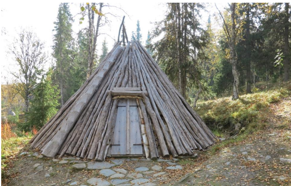
Visningskåtan när den var nyuppförd – en bågstångskåta täckt med rundvirke.
