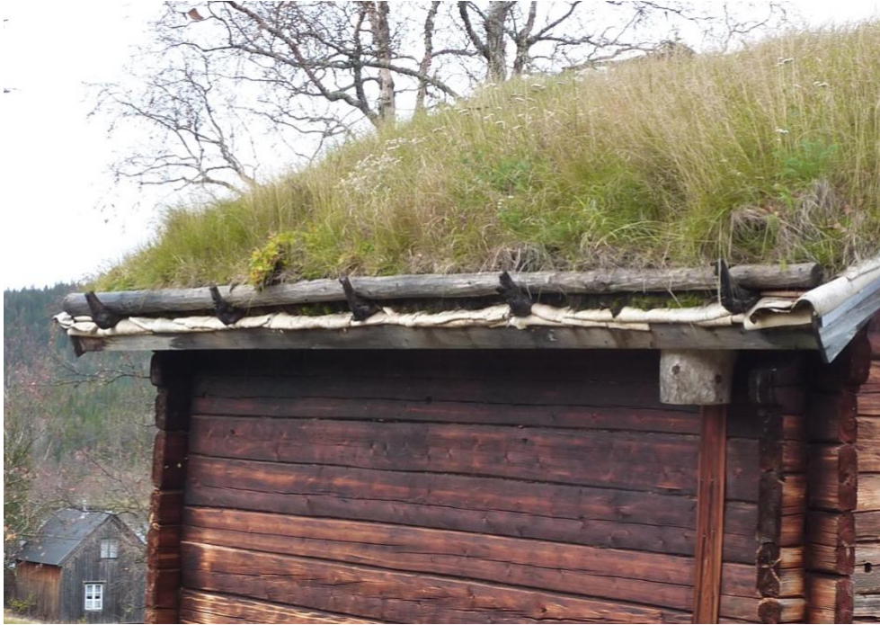
Torvtäckt tak, där näver, mullås och raftkrokar tydligt syns.
