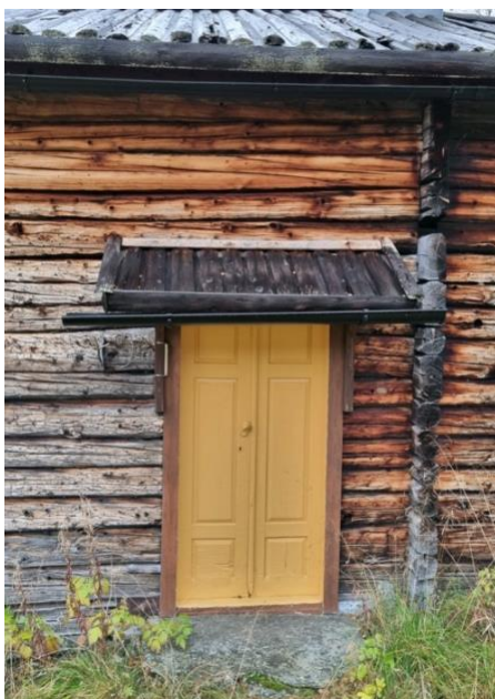
Exempel på dörrtyper – spegeldörr och enkel bräddörr.
