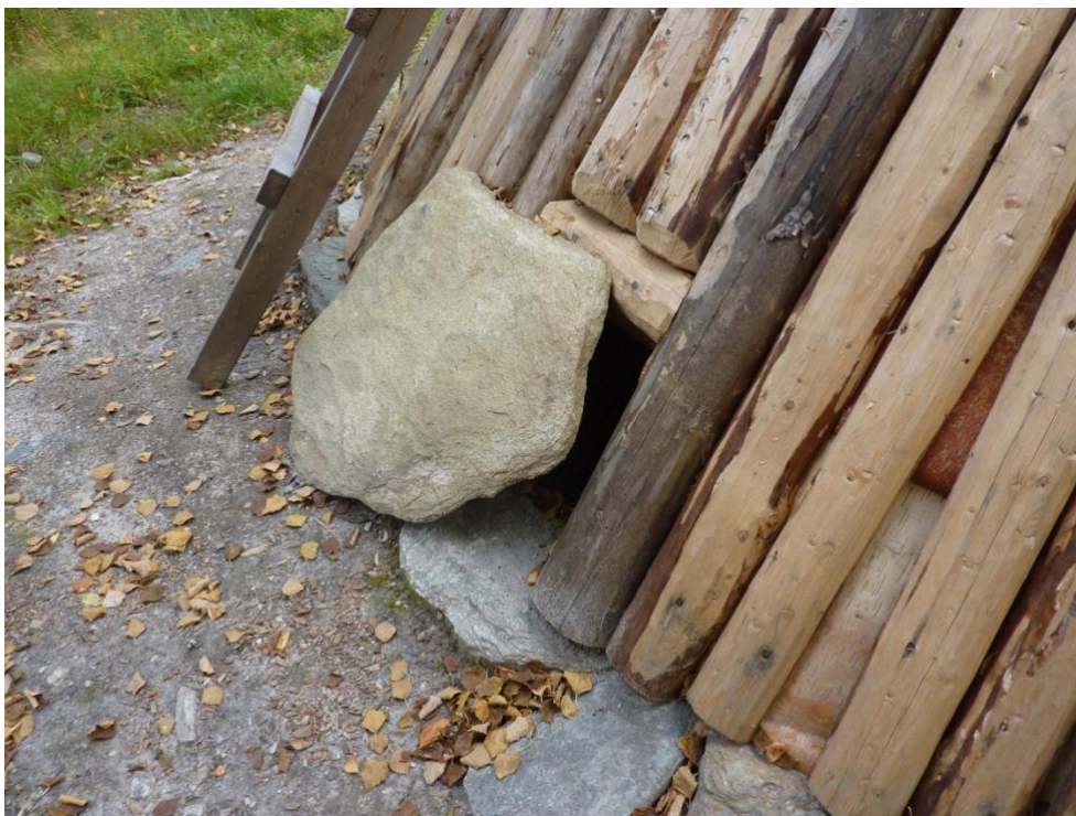
Kåtans lufthål från utsidan, med en sten som används för att täcka hålet när inte kåtan används.
