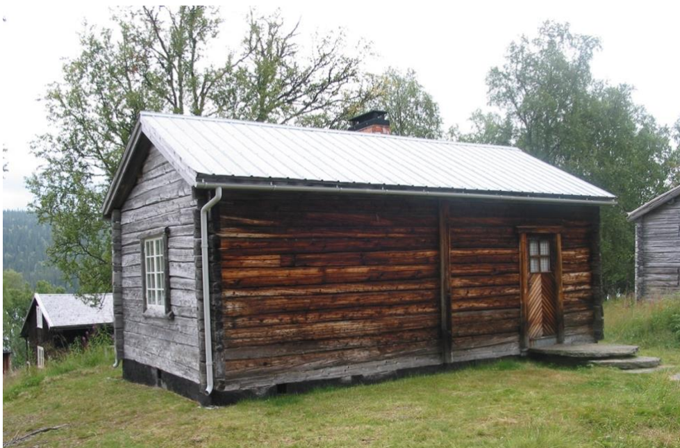
Tak av pannplåt.
