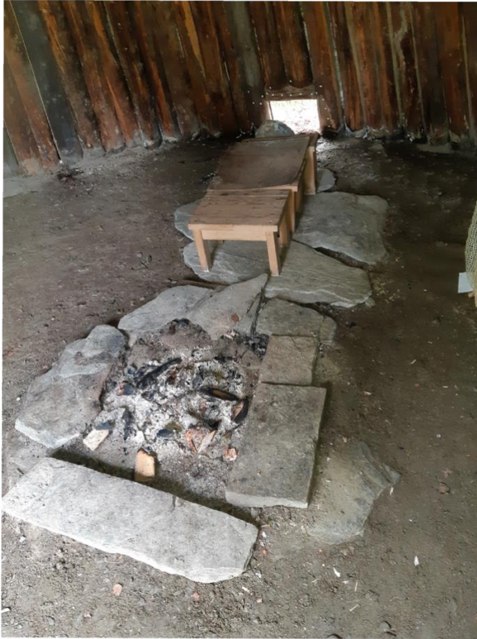
Kåtans lufthål från insidan, med aernie/eldstaden i kåtans centrum.
