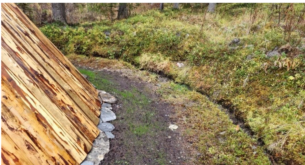
Exempel på markarbete med avvattning runt kåtan.
