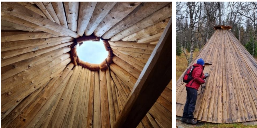
Rököppning. Täckning av lock i trä.
