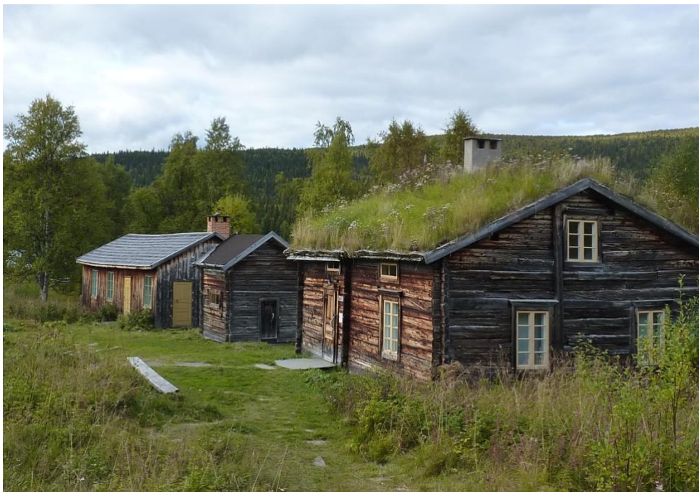
Tre olika taktäckningar sida vid sida – torv, papp och spån.
