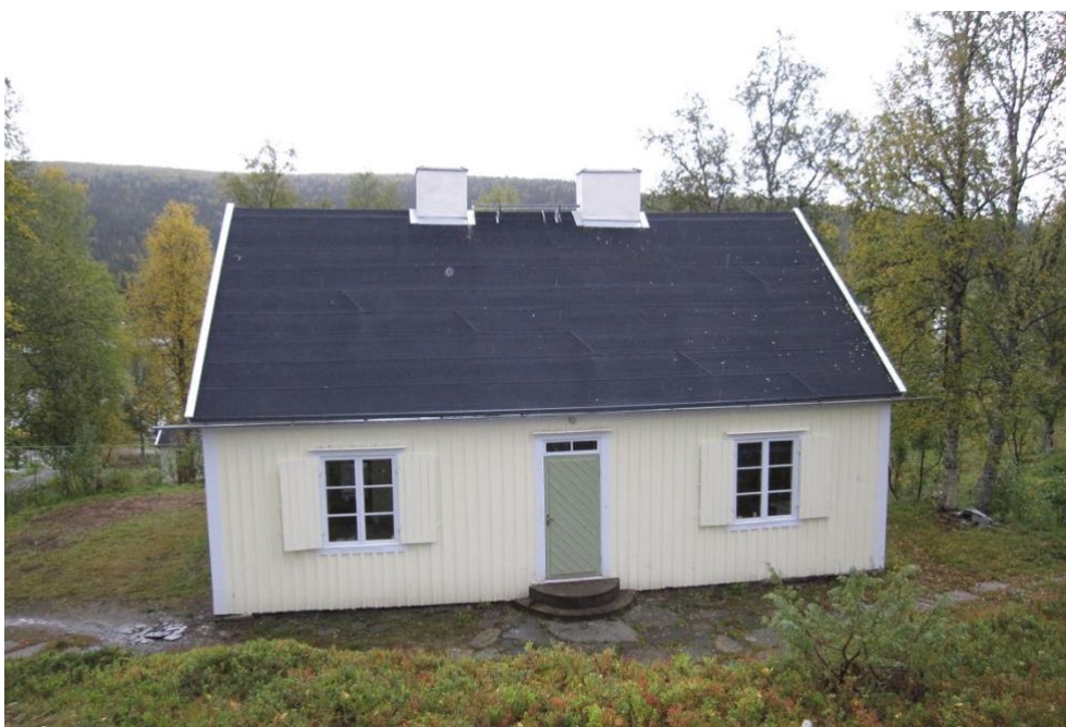
Tjänstemannabostaden från 1927, ritad av Umeås dåvarande stadsarkitekt Edvard Lundquist. Den har vid förrättningar tjänat som tjänstebostad för lappfogden, nomadskoleinspektören, lapptillsyningsmannen, läkaren, landsfiskalen, kronofjärdingsmannen och jägmästaren.
