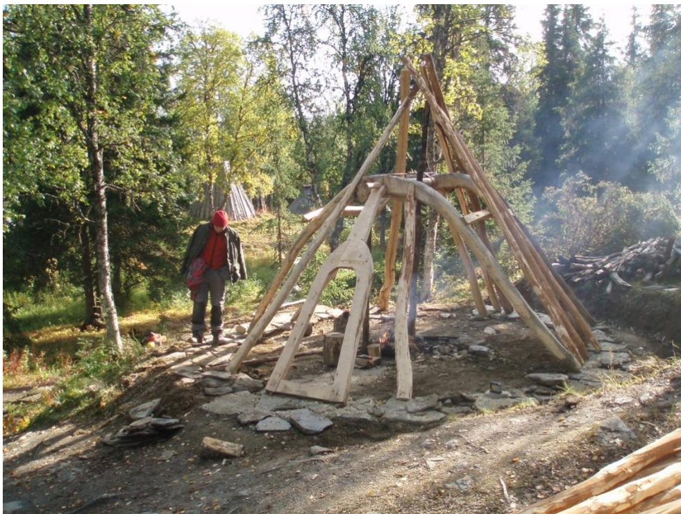
Bågstångskåta under uppförande.
