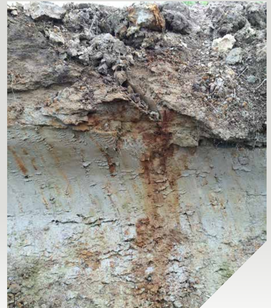
I en sur sulfatjord uppstår ofta sprickor där orangea järnutfällningar bildas
