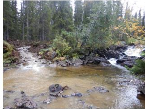
Färdigt omlöp förbi vandringshindrande hållan
