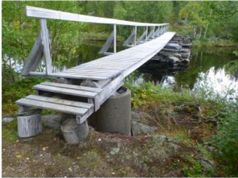
Gamla bron nedströms hängbron
