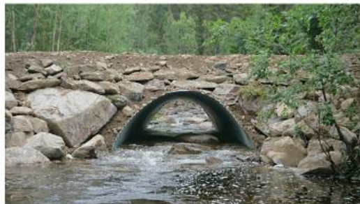
Efterbild byte av vandringshindrande trumma Gäddbäcken
