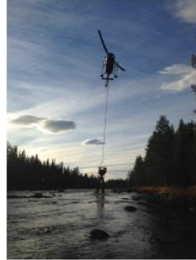
Helikoptern placerar ut grus på förberedd nacke i Marsån
