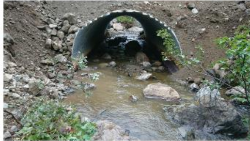
Efterbild byte av vandringshindrande trumma biflöde till Gäddsjön
