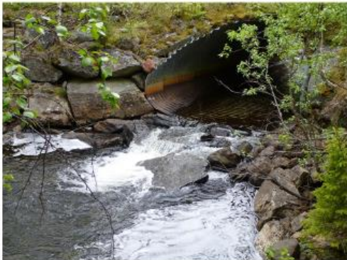
Förebild byte av vandringshindrande trumma Gäddbäcken
