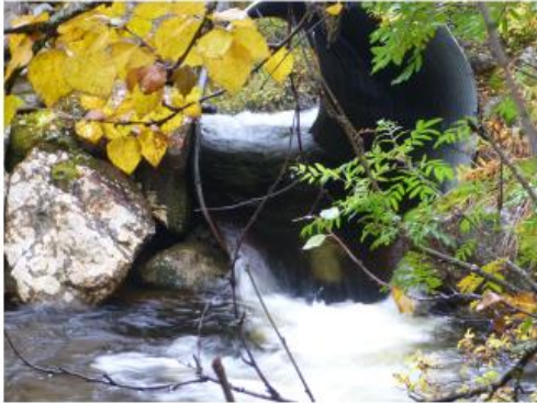
Förebild byte av vandringshindrande trumma biflöde till Gäddsjön
