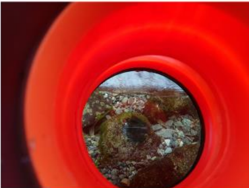
Inspektion av grusutlägg i Dainabäcken med vattenkikare
