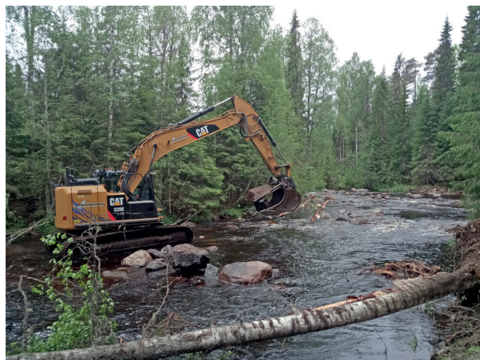
Pågående restaurering i Hörnån, Krokforsen, under 2019.
