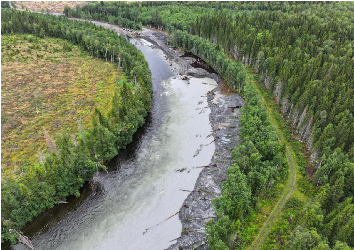
Figur 56. Grumlingsproblematik i samband med åtgärdsarbetet i Långankanalen 2023.
