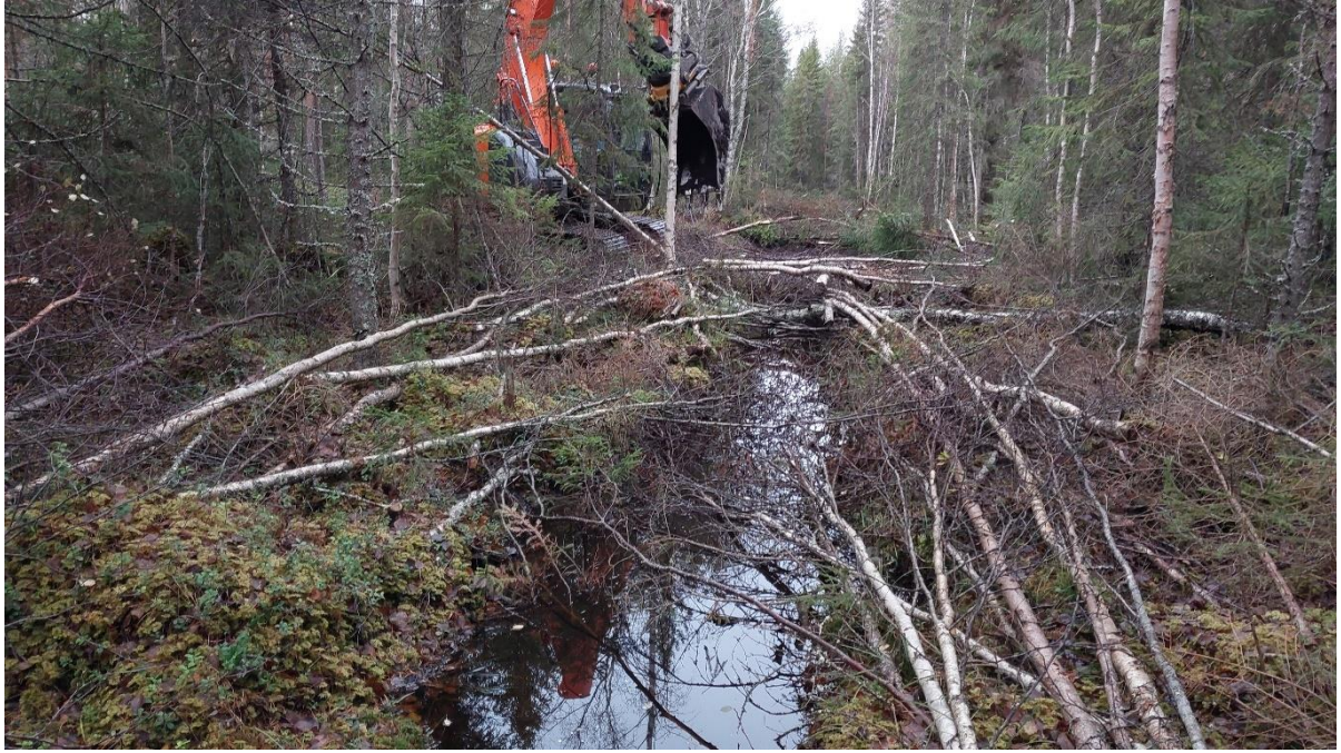
Figur 88. Före igenläggning av dike vid Sännån 2023.
