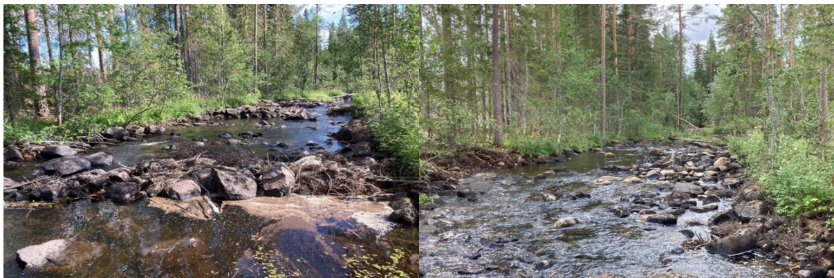
Figur 91. Till vänster i bild före restaurering strömkoncentratorer från tidigare restaurering. Till höger i bild efter restaurering, block och sten har omgrupperats för att skapa en naturligare vindling av ån, sträcka 3, Täckelån 2023.
