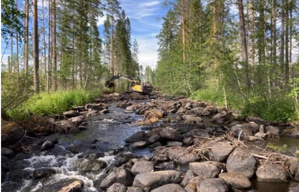
Figur 92. Före årets restaurering. En sträcka som tidigare blivit restaurerad genom att stenar grupperats i ledarmar, så kallade strömkoncentratorer, Täckelån 2023.
