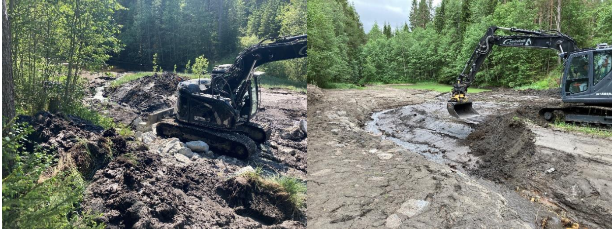
Figur 60. Efter tillståndsansökan påbörjade rivning av dammen i Fillstabäcken sommaren 2023. Sediment schaktades ur och lades delvis i dammområdet kanter.
