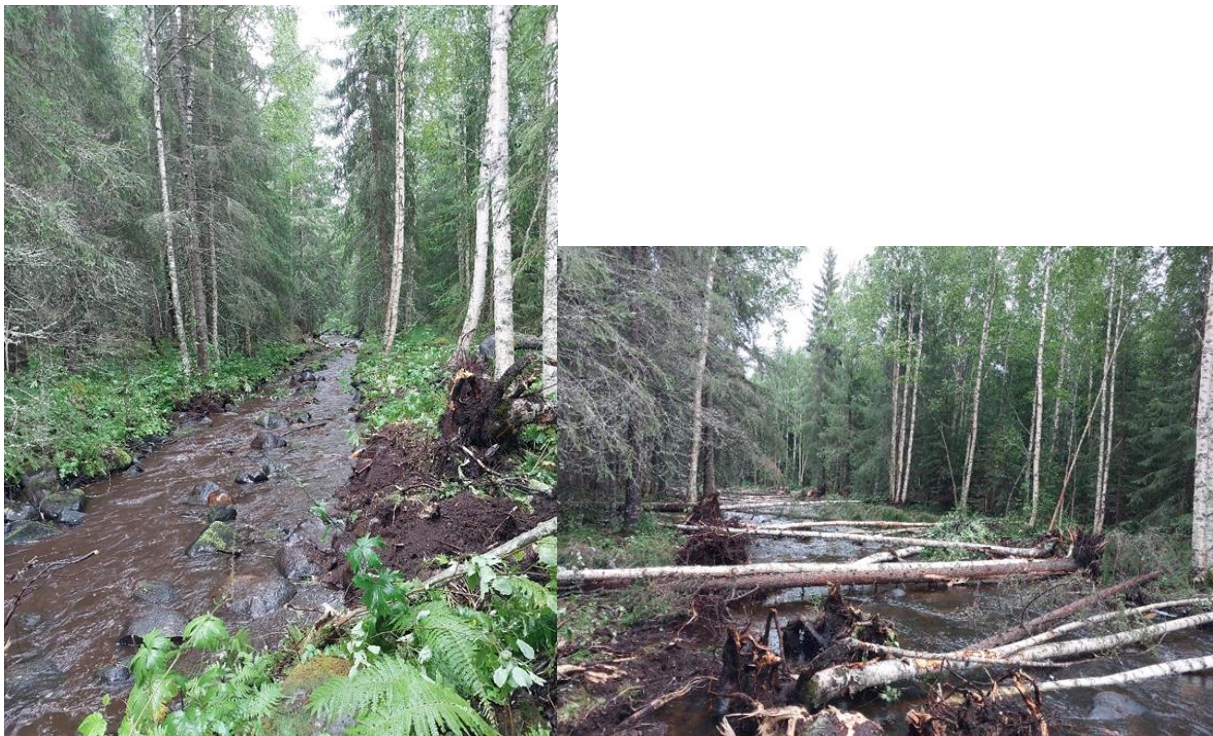
Figur 81. Till vänster i bild före restaurering av Rotån 2023, sträcka 2. Till höger efter restaurering, träd som växt på rensvallar är placerade i vattnet.
