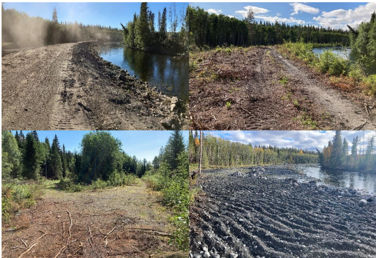
Figur 52. Fyra bilder tagna på samma plats under arbetets gång i Långankanalen under fältsäsongen 2022. Högst upp till vänster vid arbetets start och längst ner till höger efter sex veckor vid arbetets slut, Långan, Krokoms kommun.
