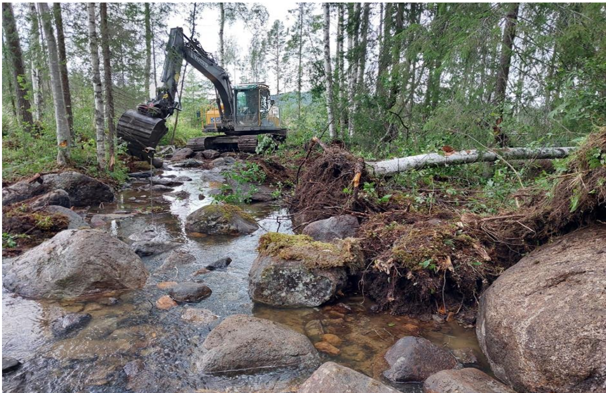
Figur 96. Samma sträcka efter restaurering, bredd cirka 4 meter. Större stenar har placerats ut i bäcken, djupare partier är skapade vilka kan fungera som ståndplats för fisk.
