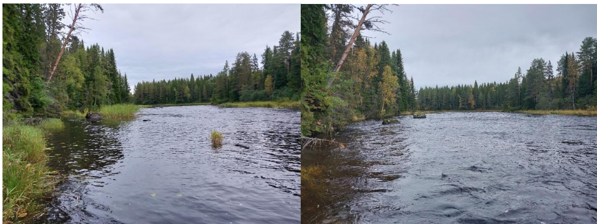
Figur 34. Nötflyn (SWEREF N 7037621, Ö 522298). Vänster bild: Före åtgärd. Rensvall stänger av en naturlig ytterkurva. Höger bild: Efter åtgärd. Fåran har återfått sin slingrighet då vattnet återigen trycks ut i ytterkurvan. En ytterligare del av rensvallen fortsatte även cirka 150 meter i nedströms riktning mot kameran, men är numera också åtgärdad.
