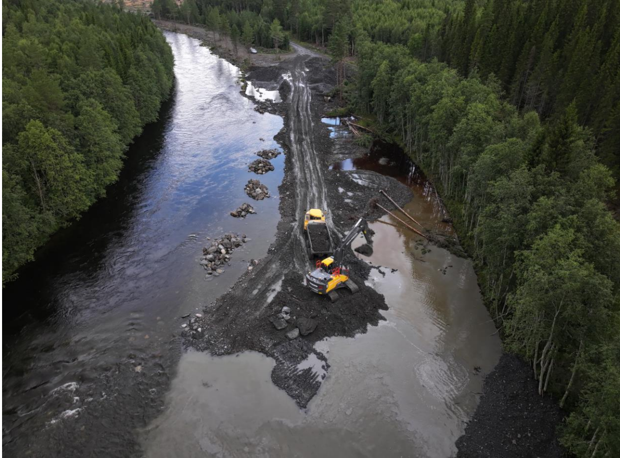
Figur 57. Arbete med dumper i åtgärdsområdet, Långankanalen 2023.
