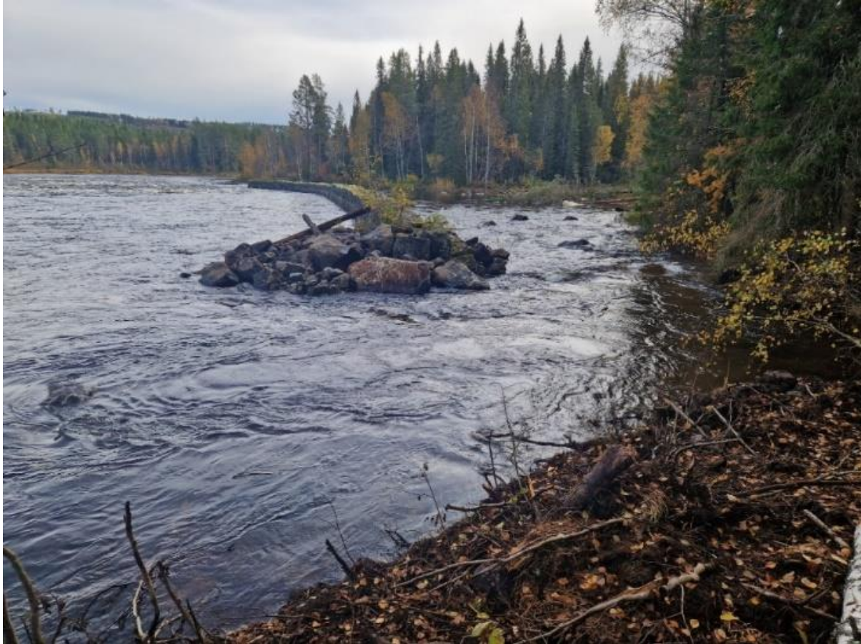
Figur 42. Omlöp förbi kilstensmuren åtgärdssträcka 7, Ammerån 2023 (SWEREF N 7035264, Ö 523337). Muren har förstärkts med block för att inte påverkas av is eller höga flöden. Åtgärdssträcka 8 synlig till höger i bild bakom muren där den tidigare avstängda sidofåran på cirka 850 meter börjar.
