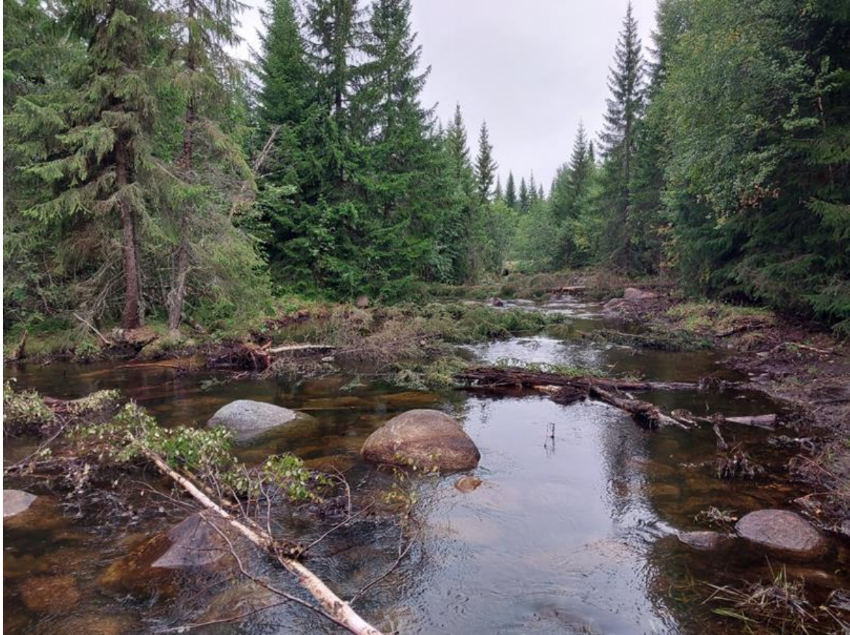
Figur 80. Efter restaurering, sträcka 1 Rotån 2023. Sten från rensvallar har placerats i ån, flikigare strandzon och aktiva svämplan har skapats.
