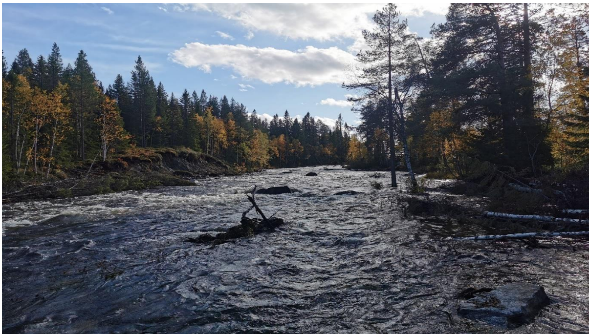
Figur 28. Efter åtgärd, åtgärdssträcka 1, Svaningsån 2023. Delar av den branta slänten till vänster i bild har använts till att bygga ut strandzonen.
