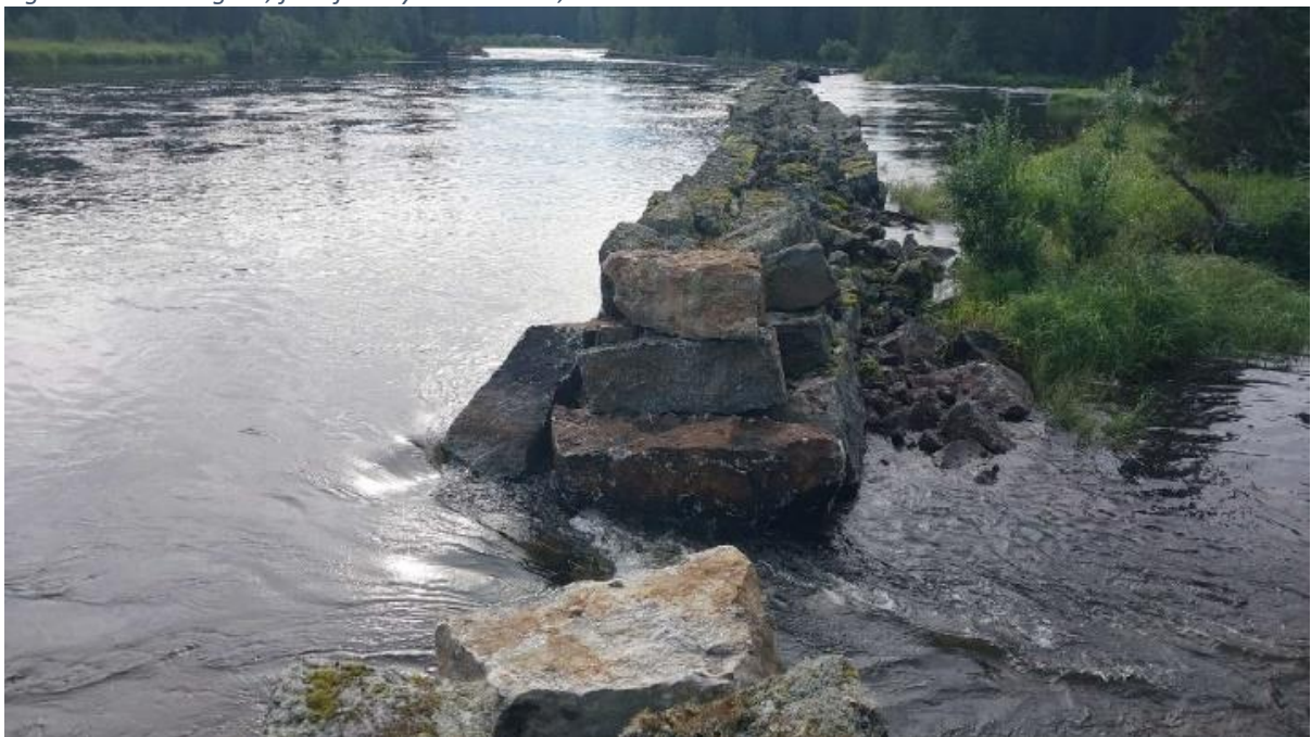
Figur 44. Efter åtgärd, foto från sydöstra sidan, Ammerån 2023.
