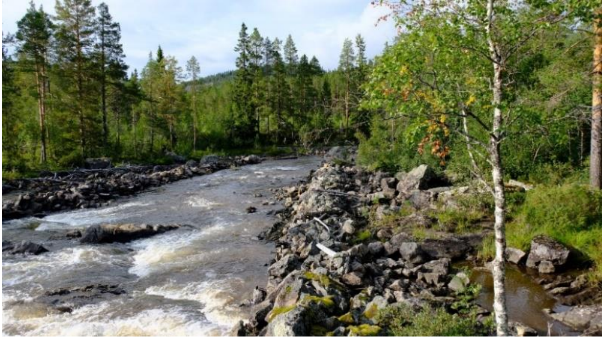
Figur 19. Kanaliserad och innesluten strömsträcka med nedsänkt basnivå, Lill-Ringsjöströmmen.
