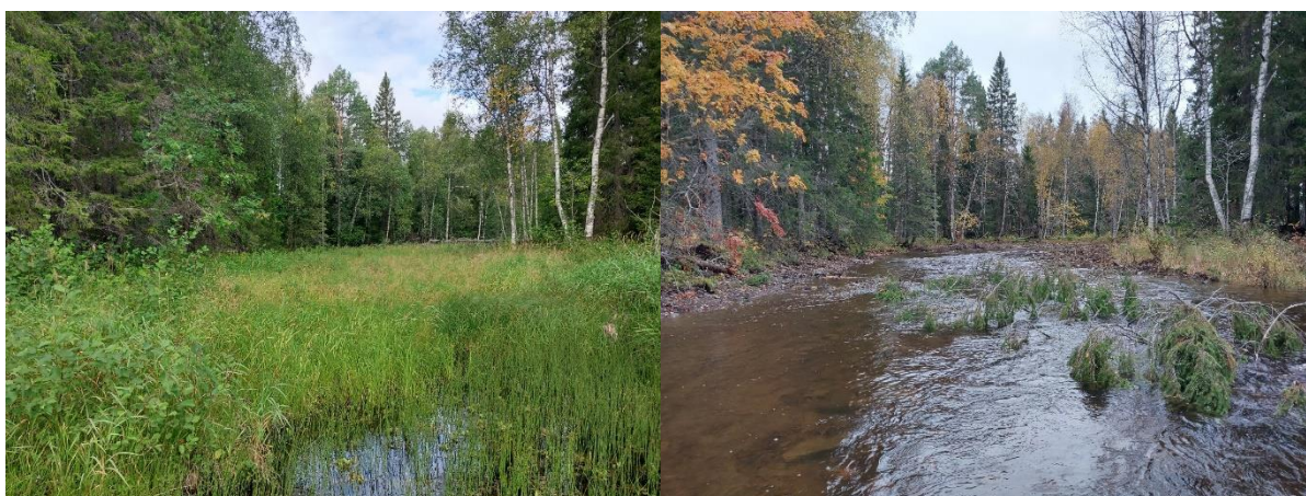
Figur 35. Nötflyn Ammerån 2023 (SWEREF N 7037644, Ö 522542). Vänster bild: Före åtgärd. Cirka 70 meter av fåran är igenväxt med cirka två meter hög vegetation. Höger bild: Efter åtgärd. Vegetationen har tagits bort och fåran har sänkts för att få in vattnet igen.
