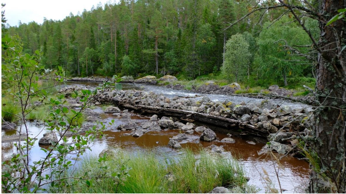
Figur 21. Stenkista vid nedre delen av Lill-Ringsjöströmmen 2023.
