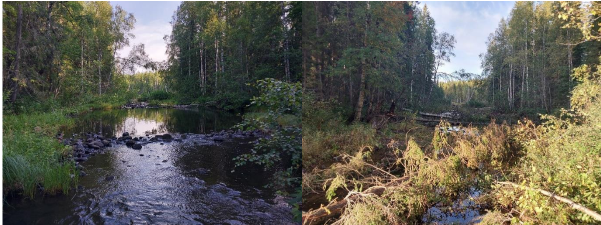
Figur 36. Nötflyn Ammerån 2023 (SWEREF N 7037455, Ö 522549). Övre bild: Före åtgärd. En troligen grävd överfördjupad hölja med trösklar uppströms och nedströms höljan. Nedre bild: Efter åtgärd. Fåran har breddats och trösklarna har justerats och gjorts om till grusbankar. Stora mängder död ved har tillförts.
