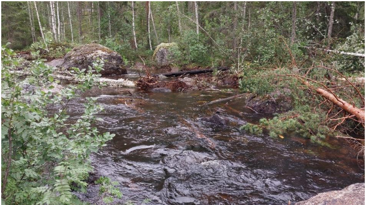
Figur 9. Efter åtgärd, öppnad ytterkurva i Staversån 2023.
