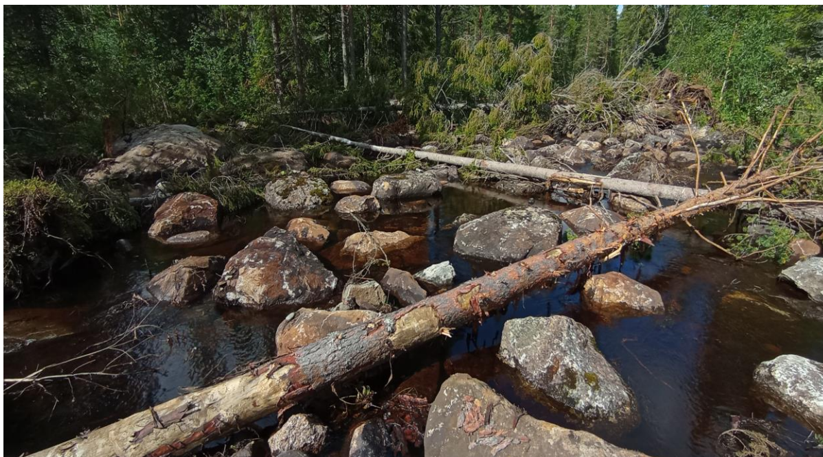
Figur 5. Efter åtgärd, område 1, Staversån 2023.
