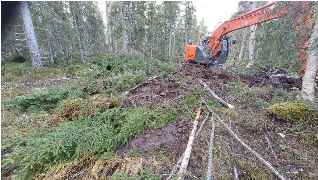
Figur 87. Efter igenläggning av dike och dikesplugg vid Sännån 2023.
