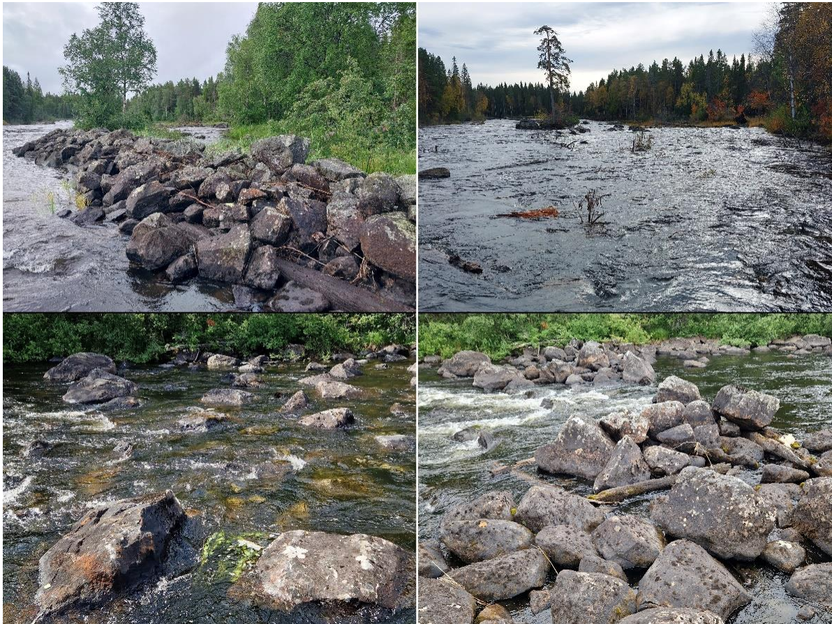
Figur 37. Åtgärdade stenkistor (övre vid åtgärdssträcka 5 SWEREF N 7035461, Ö 523249 och nedre vid åtgärdssträcka 3 SWEREF N 7035939, Ö 523027). Före åtgärd till vänster och efter åtgärd till höger, Ammerån 2023.
