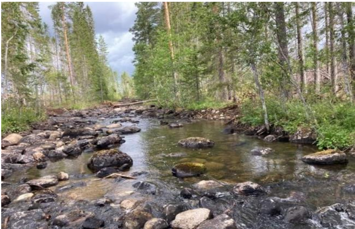
Figur 93. Efter restaurering, stenar har blivit omgruppera för att återskapa en naturligare strömsträcka med mer vatten i ytterkurvan.
