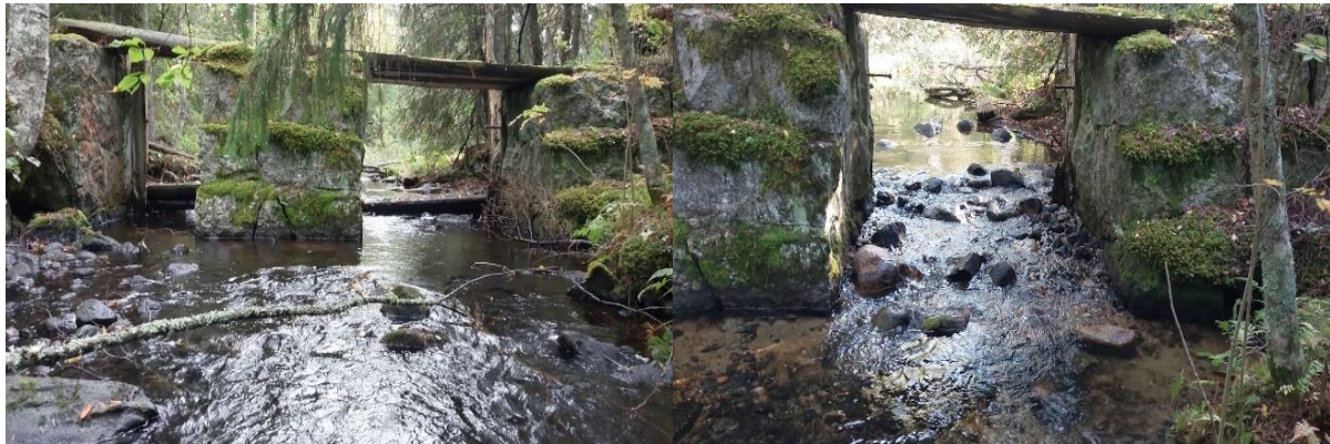
Figur 83. Till vänster i bild en flottningsrest med fördämningsvall, brofundament och bottenstockar som utgör vandringshinder i Öster-Rotsjöbäcken 2023. Till höger i bild efter manuell restaurering, passagen har blivit vandringsbar för fisk när bottenstockar plockats bort.
