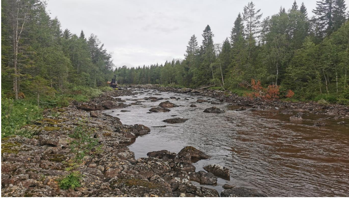
Figur 29. Före åtgärd, åtgärdssträcka 2, Svaningsån 2023.
