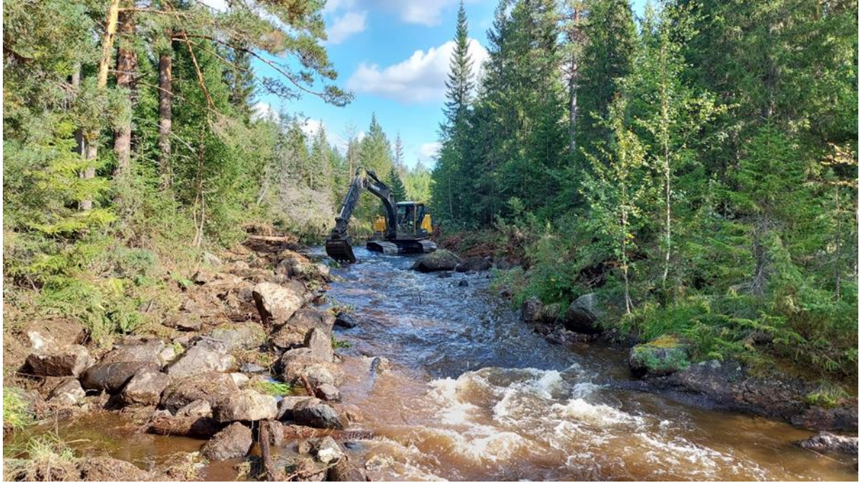
Figur 76. Före restaurering Ovån 2023, en turbulent och djup kanal.
