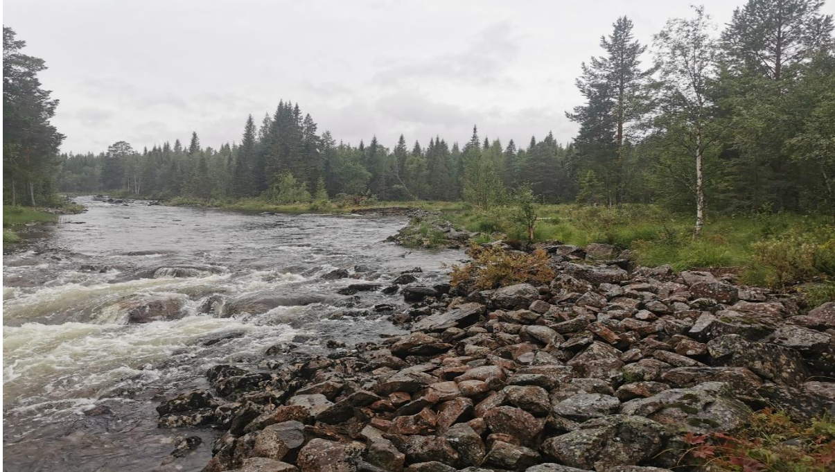
Figur 31. Före åtgärd, åtgärdssträcka 3, Svaningsån 2023.
