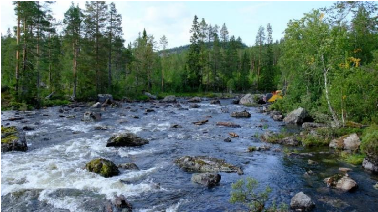
Figur 20. Samma sträcka efter åtgärd. Utan inneslutning och återställd basnivå kan vattendraget bredda i sidled. Större block skapar dynamik och sänker vattenhastigheten, Lill- Ringsjöströmmen.
