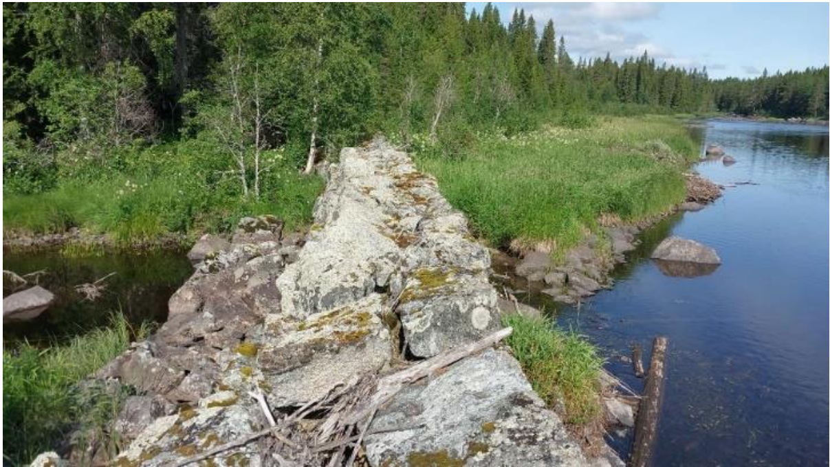
Figur 43. Innan åtgärd, foto från sydöstra sidan, Ammerån 2023.
