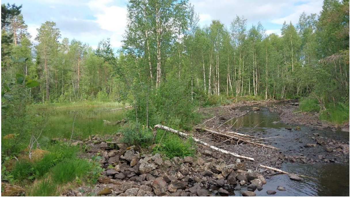
Figur 15. Rätad del av Abborrhvattenån före åtgärd 2023.
