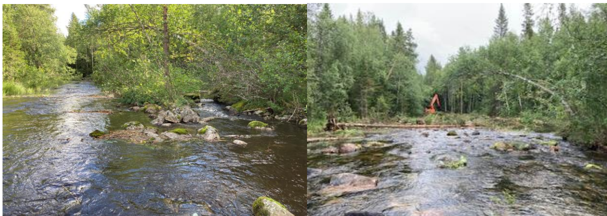
Figur 70. Efter restaurering Norån 2023, åtgärdssträcka 1, samma som i bilden ovan men i nedströmsvy. Till vänster i bild, en kanaliserad sträcka med en rensvall beväxt med träd och sly som stänger av ytterkurvan. Rensmassorna är använda till att bygga upp botten, bromsa vattnet och för att styra in mer vatten i ytterkurvan. Till höger i bild efter restaurering, ytterkurvan är öppnad, vattendraget breddat, stenar omgrupperade och död ved är placerat i vattnet. En mer varierad ekologiskt funktionell strömsträcka har blivit återskapad.
