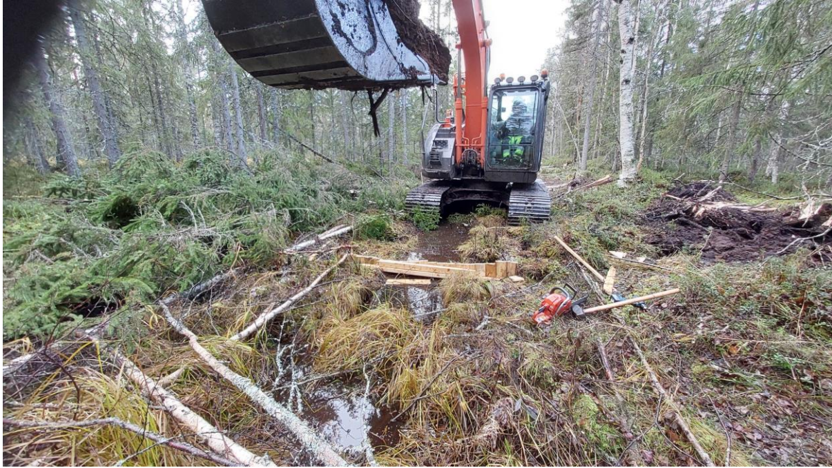
Figur 86. Dikesplugg av råspont vid Sännån 2023.
