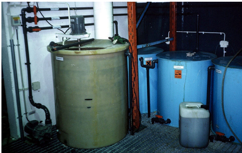
Figur 6. Tankar med hälsoskadliga och frätande kemikalier på en ytbehandlingsindustri (Arkivbild Länsstyrelsen Jämtlands län).
