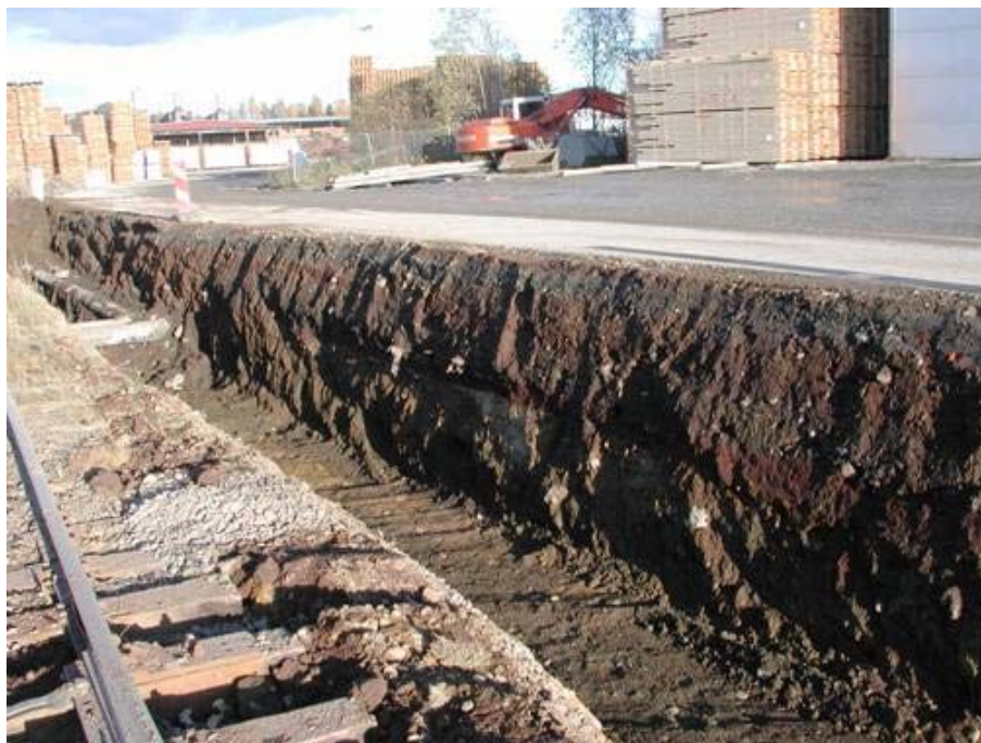
Figur 10. Kisaskaskikt i vägen och spårbädden intill kisaskaytan på området för gamla timmerfickan och gamla såghuset. Foto: Karin Olsson, länsstyrelsen Z-län.
