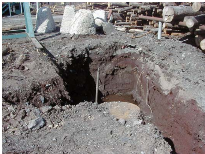
Figur 26. Exempel på kisaska-förekomst på industriområdet, här påträffad vid schaktarbeten på timmerplanen i västra delen av sågverksområdet. Foto: Nils-Erik Werner, Krokoms kommun.
