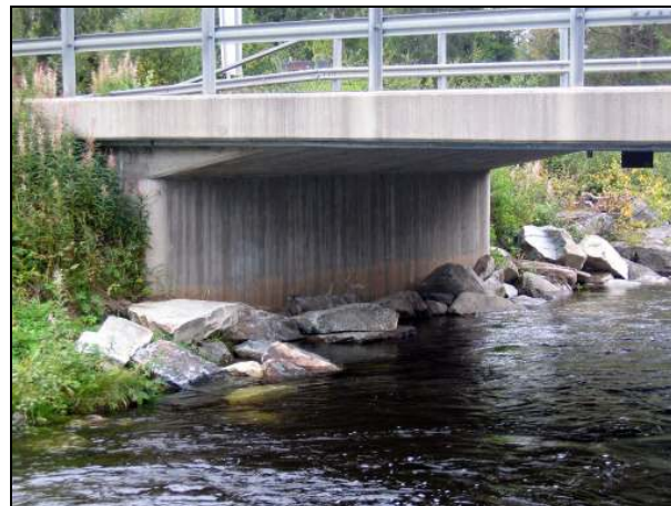
Passage efter åtgärd. Nu finns en strandremsa av stora stenar som fungerar utmärkt som markeringsplatser och passager för utter. Redan efter några veckor fanns utterspillning på stenarna under bron. I och med denna åtgärd har man ökat sannolikheten för att uttern passerar under bron istället för över vägen. Strandremsan fungerar även för andra djur som exempelvis räva, grävling och mink.
