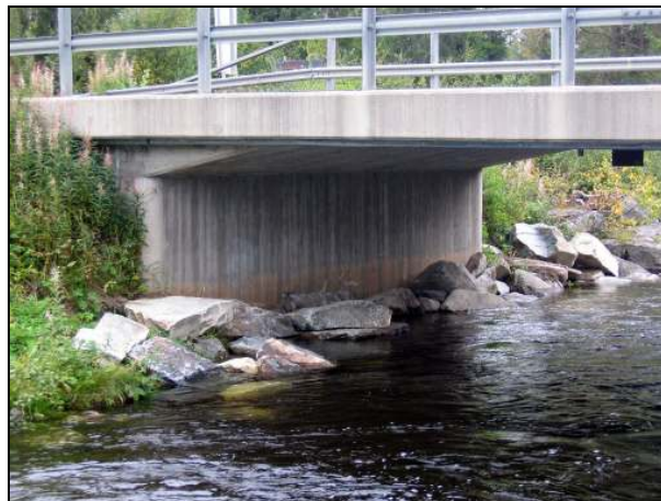
Passage efter åtgärd. Nu finns en strandremsa av stora stenar som fungerar utmärkt som markeringsplatser och passager för utter. Redan efter några veckor fanns utterspillning på stenarna under bron. I och med denna åtgärd har man ökat sannolikheten för att uttern passerar under bron istället för över vägen. Strandremsan fungerar även för andra djur som exempelvis räv, grävling och mink.
