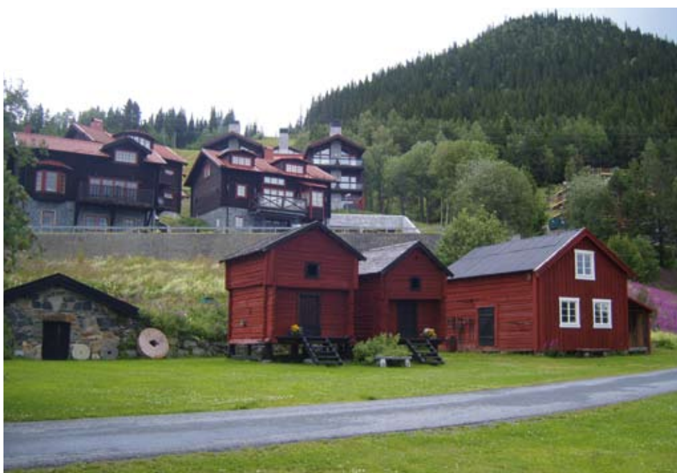
Fritidshus som kryper nära in på den känsliga miljön i Tottens by. Foto: Johan Looock 2008.
