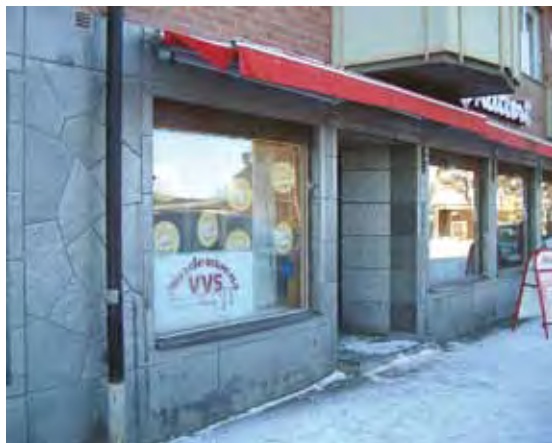
Fig. 16. Plattor från Offerdalsskiffer på byggnad från 1950-talet i Hornsberg, Frösön (Tages konditori m.m.) Foto: Johan Looock 2004. (Källa: Filmen om Gusta och Offerdalsskiffer från 1958.)
