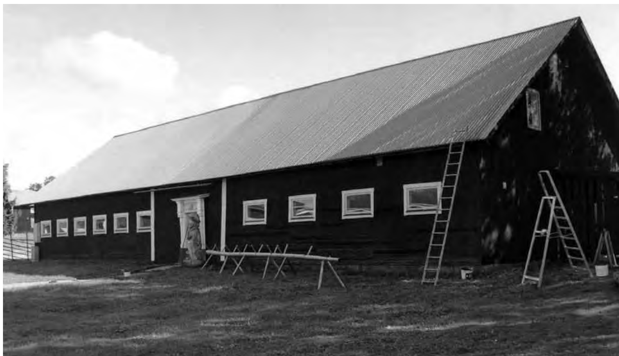
Fig. 8. Talcumfabrikens kvarnbyggnad i Strömsund. Foto: Jamtli, Ove Hemmendorff 2001.
