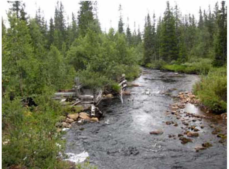
Dämningen i kanalens inlopp från Lillhärjeån i riktning mot Lillhärjäbygget, augusti 2007.
