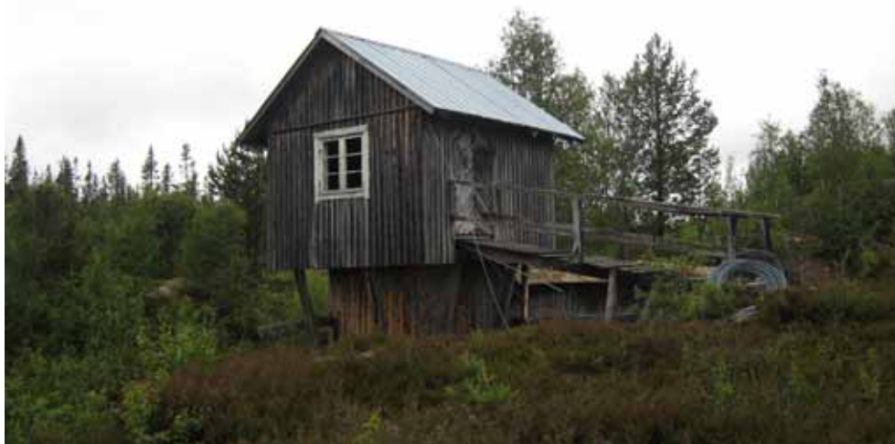
Kraftverkkåken mot sydväst, juli 2007.
