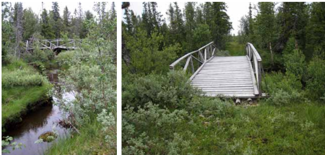
Brynnbron och Brändvägen mot sydöst, Brynnbron mot norr, riktning Brända, juli 2007. juli 2007.
