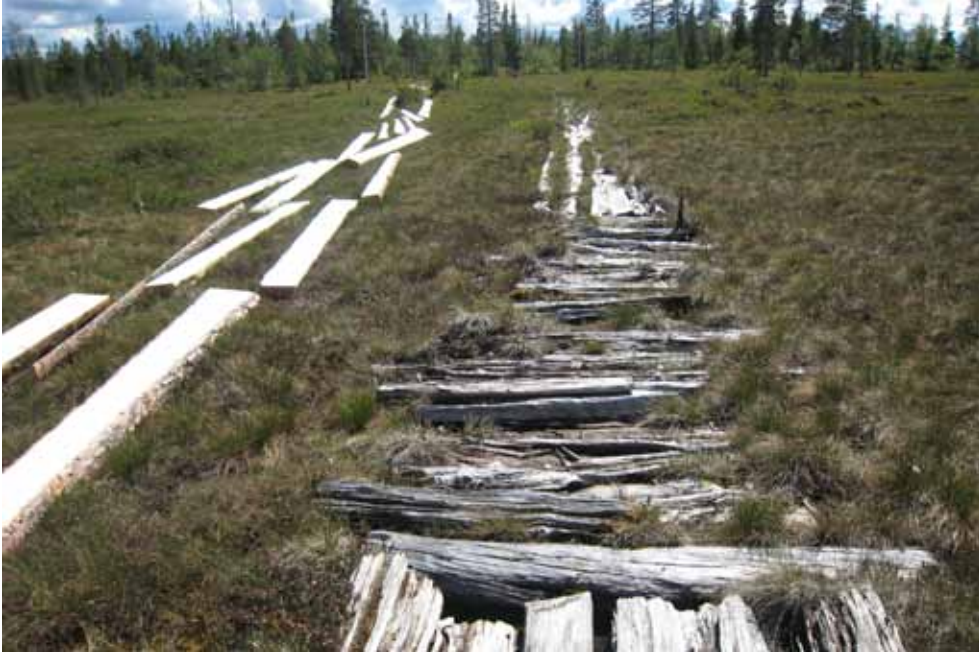
Kavelbro vid Kärringnålbrottet i riktning mot Lillhärjäbygget. En lång kavelbro för häst byggd under 1900-talets första år över myren Kärringnålbrottet på Brändvägen. En ny spång byggs vid sidan av den gamla som i dag är kulturlämning, juni 2008.
