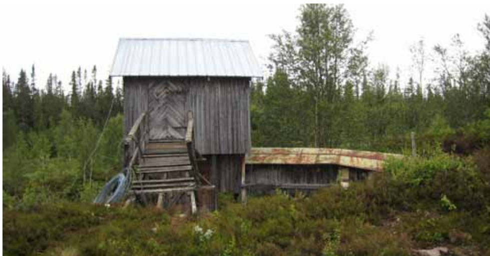
Kraftverkkåken mot söder, juli 2007.
