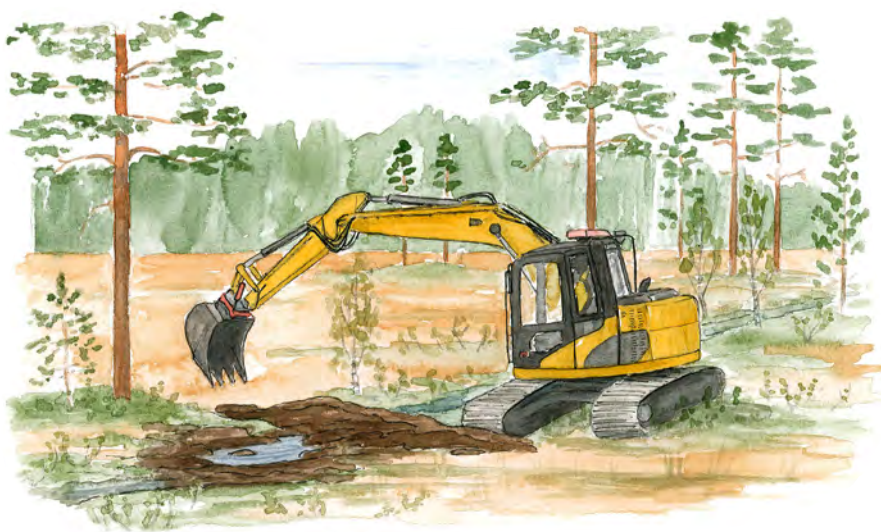
Till vänster: Grävmaskin på en stockmatta och som bygger en plugg.
