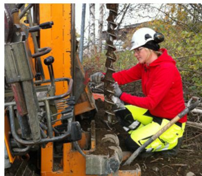
Konsult som provtar mark med skrubborr.
