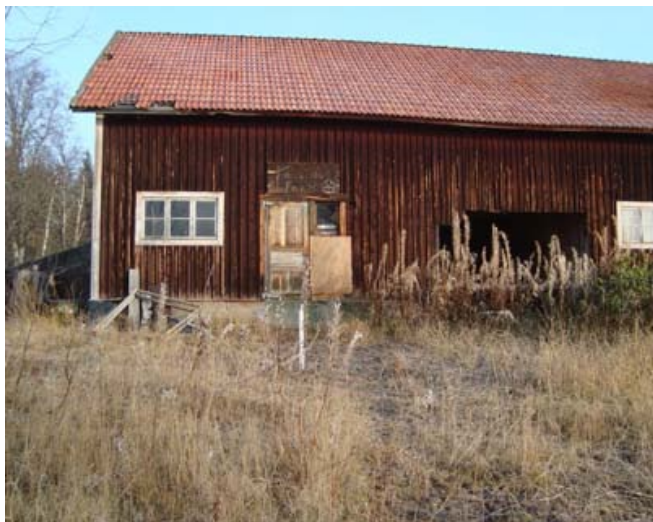
Bild 18. Tornäs träimpregneringsanläggning. Foto: Länsstyrelsen Jämtlands län.
