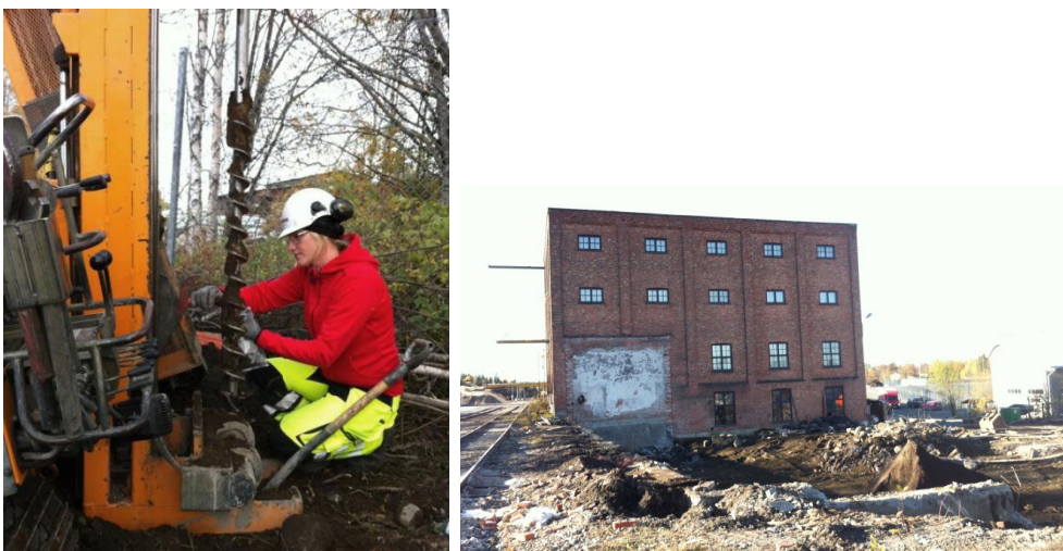
Bild 11–12. Bild från undersökningar oktober 2015 samt rivningsplatsen för den gamla verkstaden och lokstallet som hörde till sulfittfabriken. Foto: Länsstyrelsen Jämtlands län.
