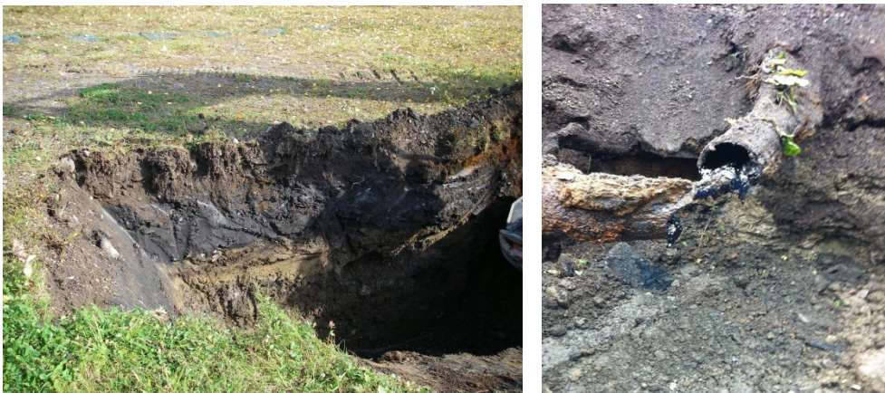
Bild 20–21 Svarta rester från ett koksupplag och en läckande ledning inom gasverksområdet i Östersund. Foto: Länsstyrelsen Jämtlands län.
