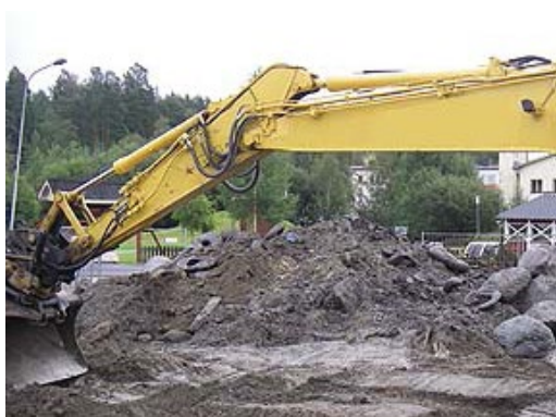
Bild 7: Sanering vid före detta bensinstation i Bräcke. Foto: Bräcke kommun
