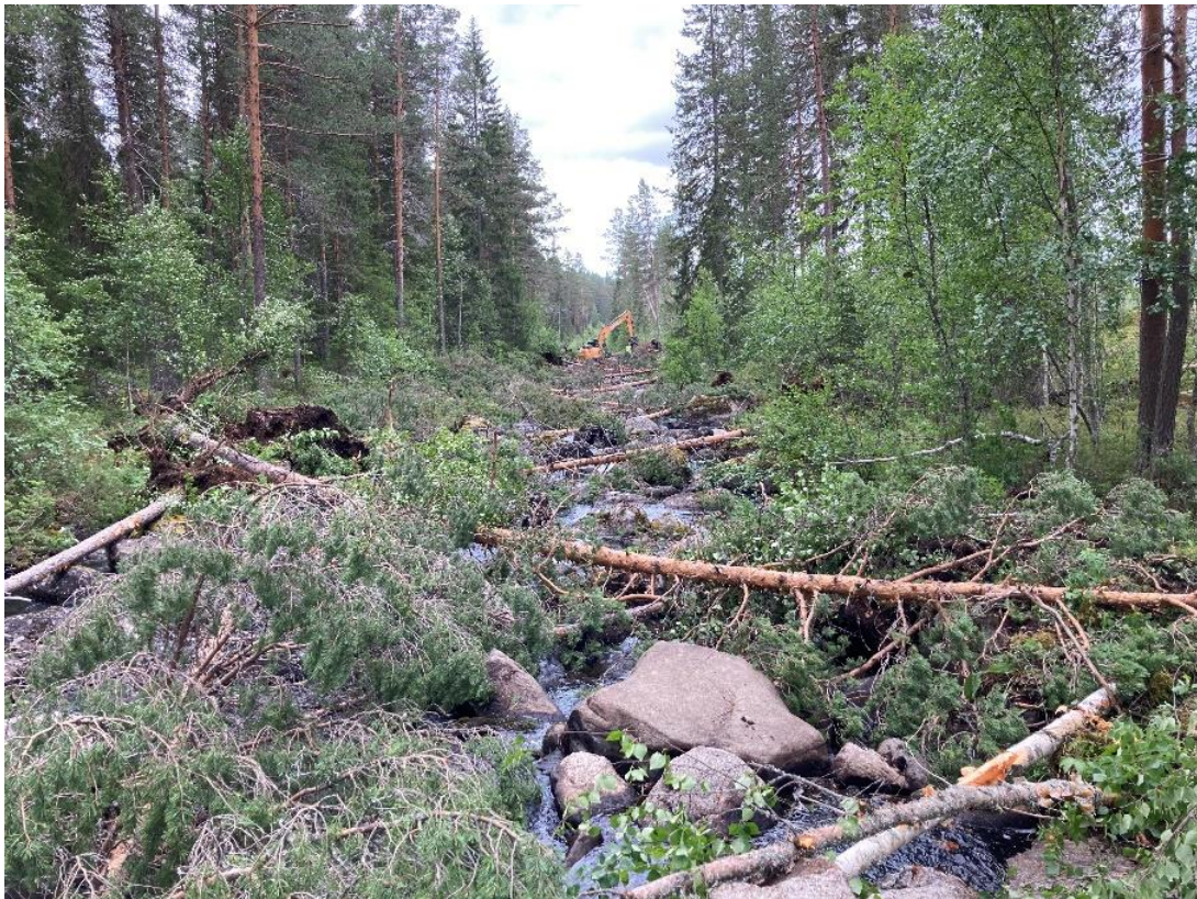
Figur 13. Laxsjöbäcken efter restaurering, bild tagen uppströms
