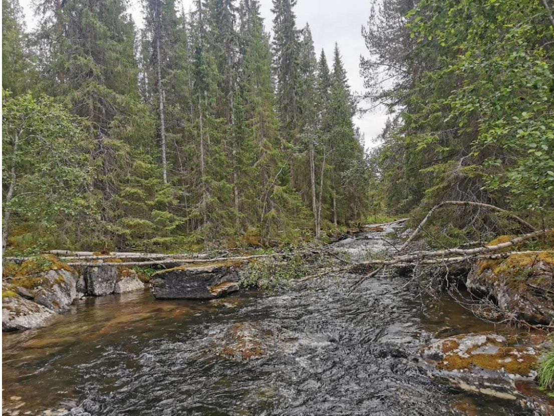
Figur 58. Sidofåra vid Kringeledan, foto taget uppströms före restaurering.
