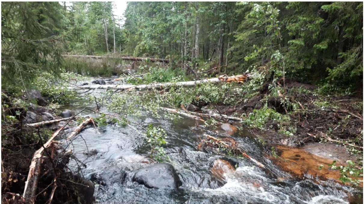
Figur 64. Samma sträcka efter restaurering i Rotån. Block, sten och död ved har återförts vattendraget. Vattendraget har breddats och varierande ström- och djupförhållanden har skapats.
