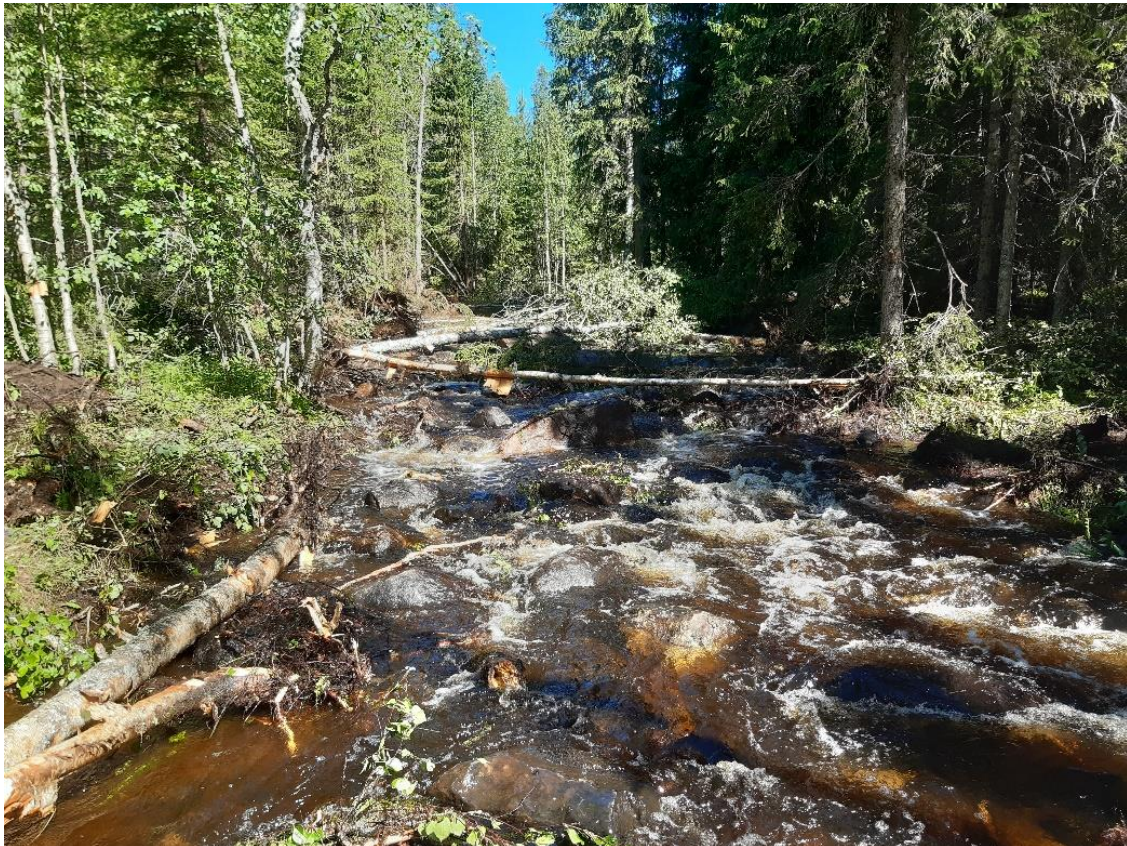
Figur 56. Efter restaurering Nällsjöån.
