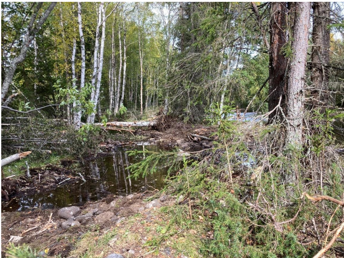
Figur 49. Efter restaurering, schaktvall vid Kvarnstranden i Fuan.
