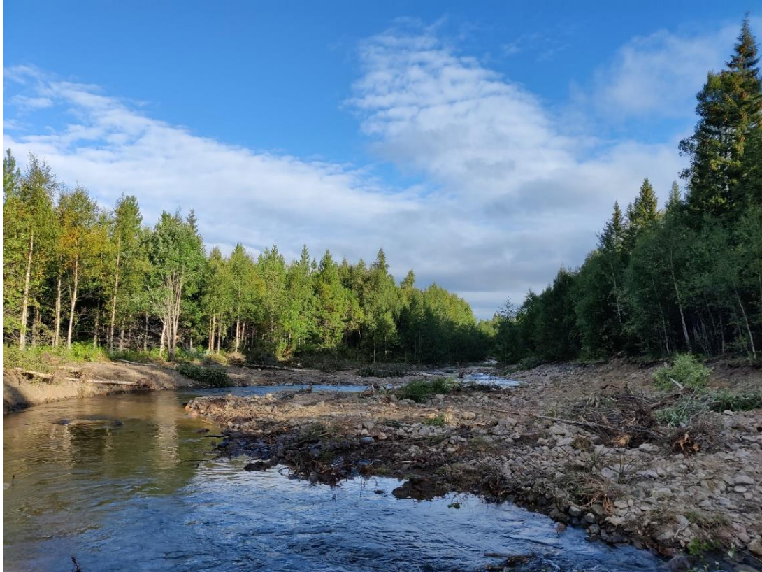
Figur 25. Efter genomförda åtgärder i Bastuån. Bild tagen nedströms.
