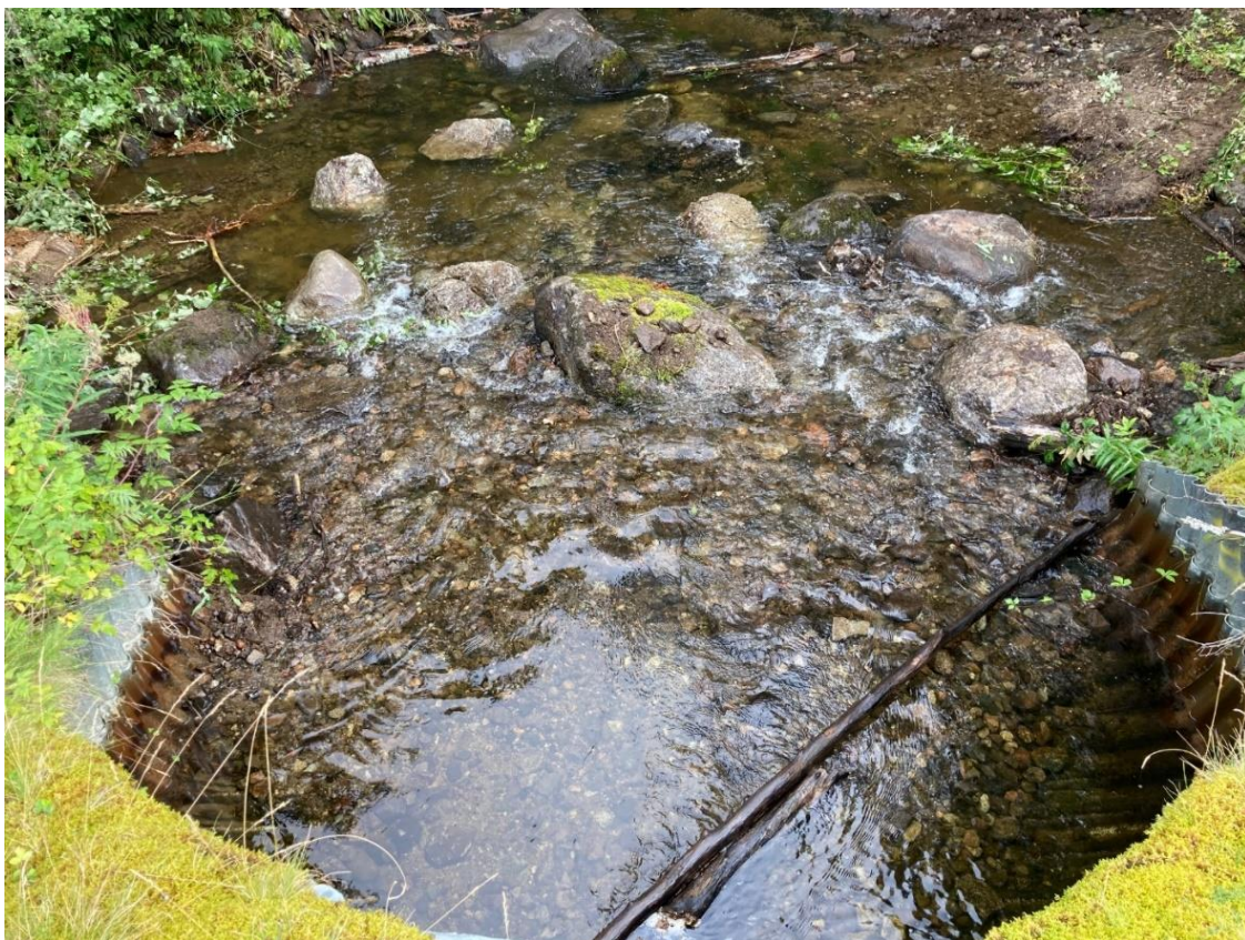
Figur 18. Vägtrumma i Målån efter åtgärd, bild tagen ovanifrån
