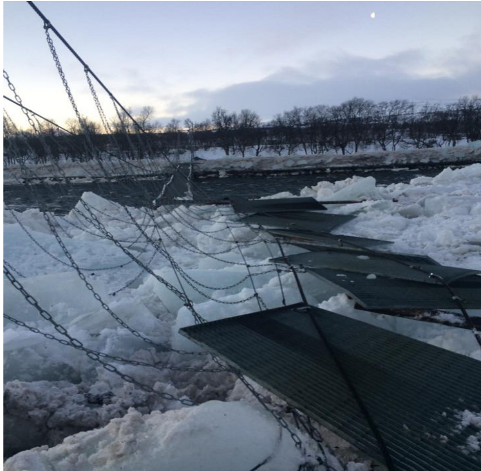
Figur 19. Bron över Handölan, efter kraftig snösmältning december 2016. Foto: Erik Gardfall, STF.
