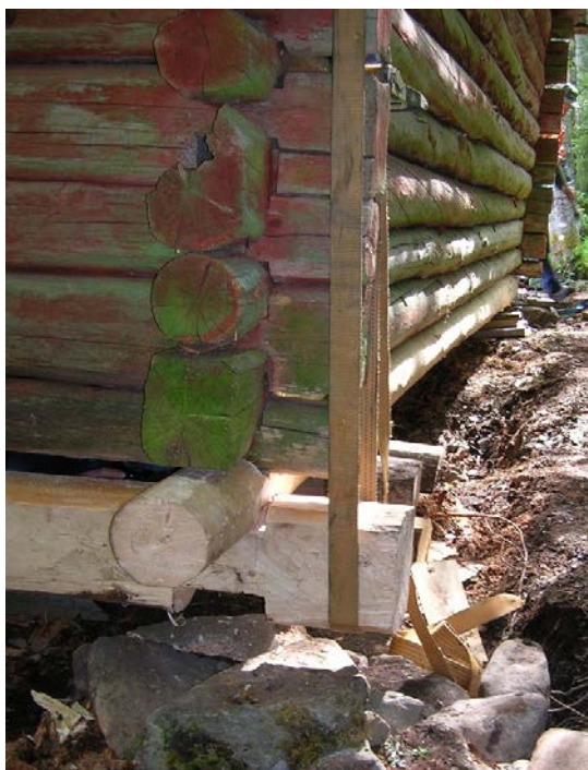
Byte av syll på lada.
