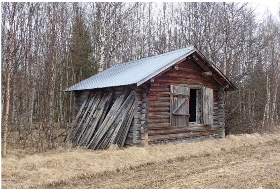
Lada nr 8. Ladan står i skogskanten och har en sparsam lavflora förutom längst ner vid den nordvästra knuten (synlig mitt i bilden) där flera intressanta arter växer.
