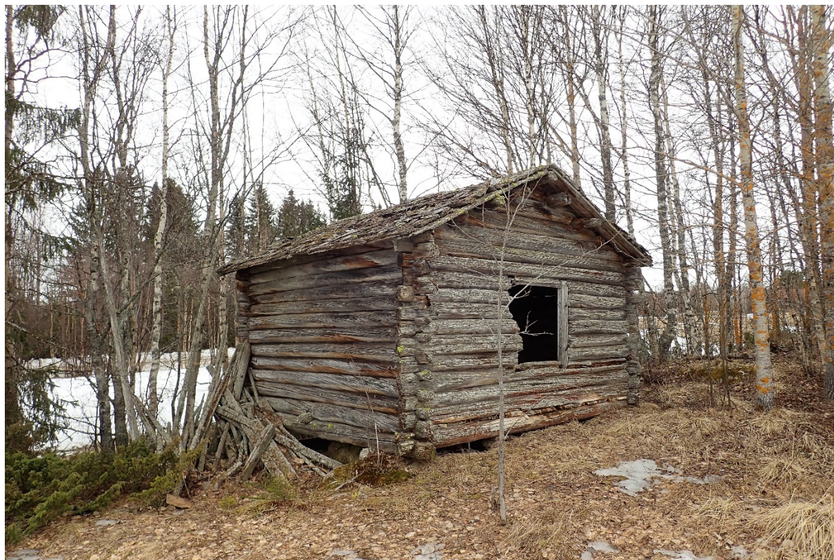
Lada nr 4. Här syns den norra gaveln där varglav förekommer både på väggen och knuten (ett 100-tal bålar) och på takutsprånget.
