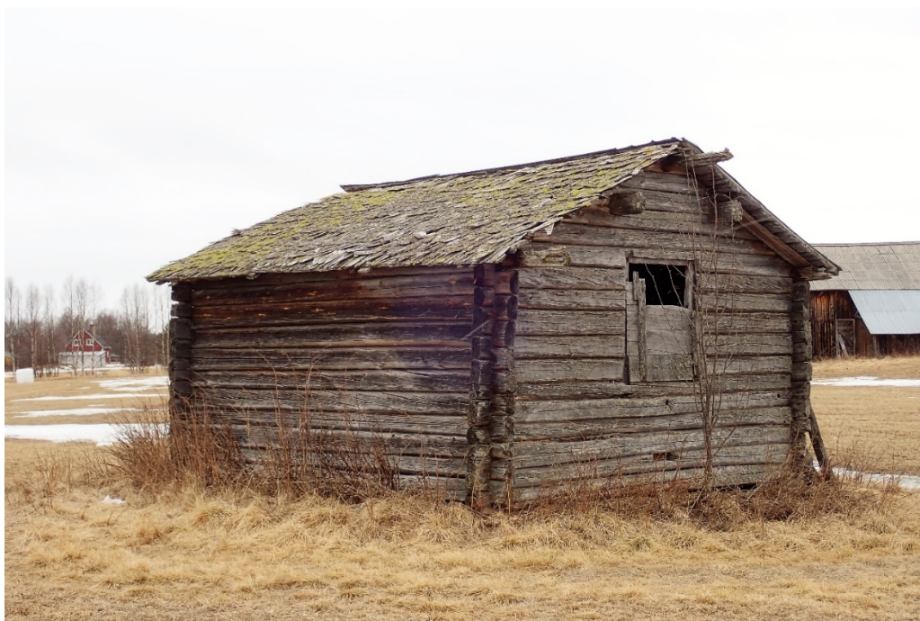
Lada nr 6. Precis som nr 5 har den här ladan bilade stockar. Sydöstra taksidan lyser gult av varglav. Här syns också den nordöstra gaveln som förutom taket är rikast på lavar.
