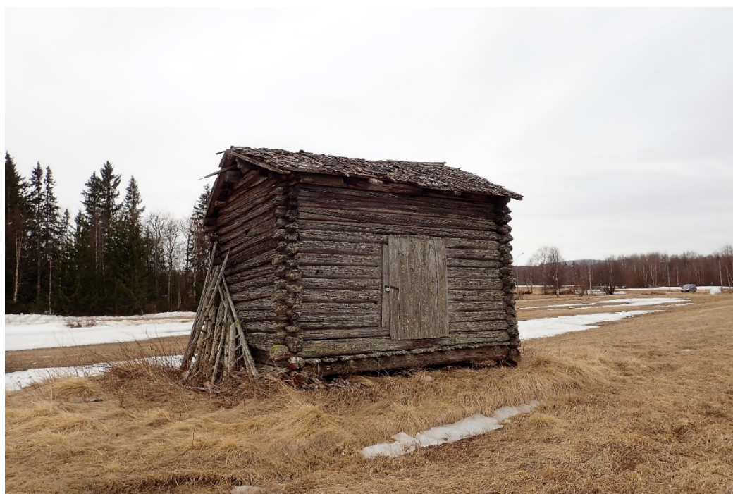
Lada nr 7. Här syns den nordvända taksidan, som endast har enstaka varglavsålar samt de lavrika väggarna mot norr och öster.
