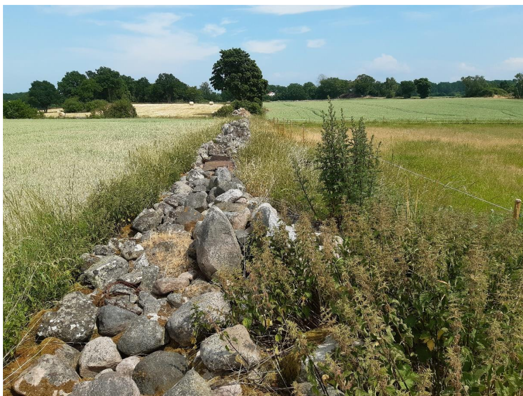
Stenmuren ligger mellan två åkrar och omfattas av grundvillkor. Kylinge, Kläckeberga socken, Kalmar kommun. Foto Anders Eriksson
