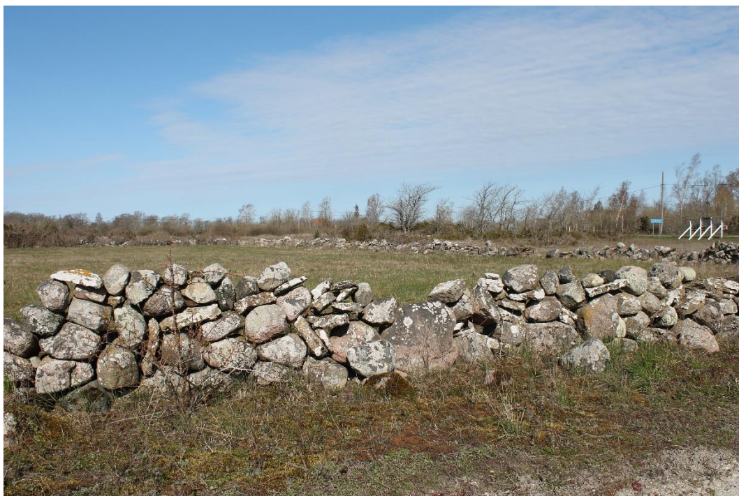
Enkelmur som byggts med åkersten. Persnäs socken, Borgholms kommun. Foto Ann Moreau
