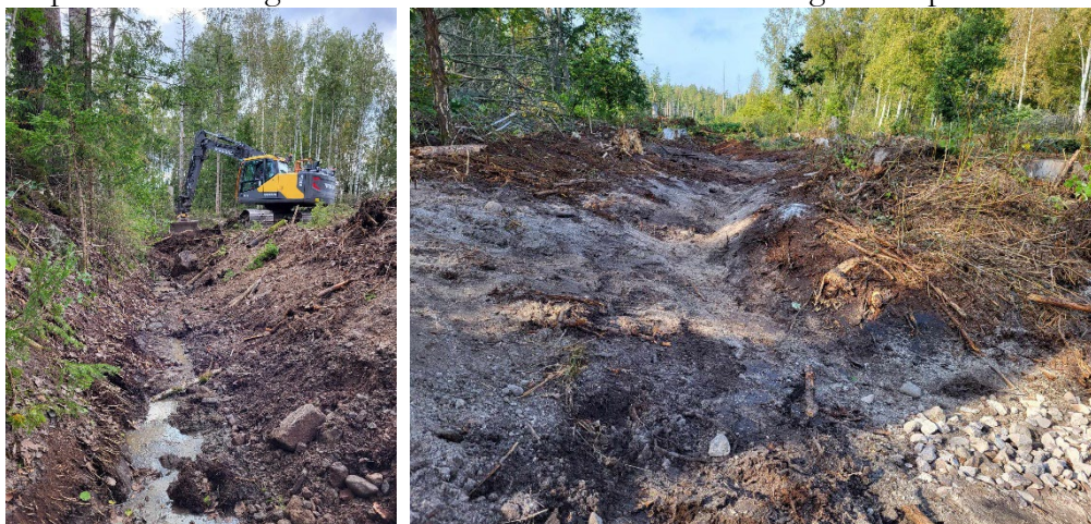
Figur 1: Till vänster: det grävda diket som anlagts för att dränera våtmarksmiljön läggs igen med grävmaskin. Till höger: Det gamla utloppet från våtmarken har skrapats fram och förväntas återaktiveras vid höga vattenflöden. Åtgärden återksapar en våtmarksmiljö på cirka 2 ha i Hornsö-Ekopark. Åtgärden är finansierad med medel från Naturvårdsverket.
