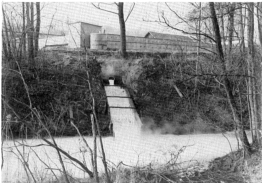
Eds bruks utsläppspunkt i Storån. Avloppsvattnet från cellulosafabriken är till följd av regleringar uppströms tidvis det enda vatten som tillförs åfårans nedersta del. Ovanför strandbrinken syns kanterna på sedimenterings- bassängen.
