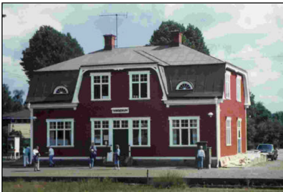
Virserums station som den ser ut idag (Foto: VHVnJ).
