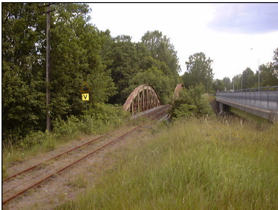
Bågbro vid Gårdveda norra banvaktshus.
