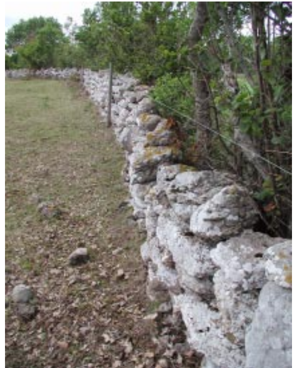
Enkelmuren skulle läggas upp på våren och den av byn inhyrde gärdesvaktaren underhålla muren under växtsäsongen.
