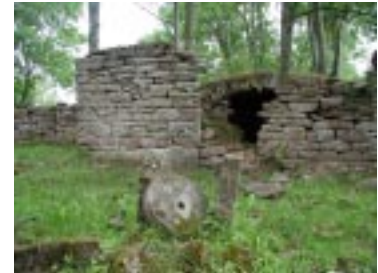
Jordkällare med stenvälv
