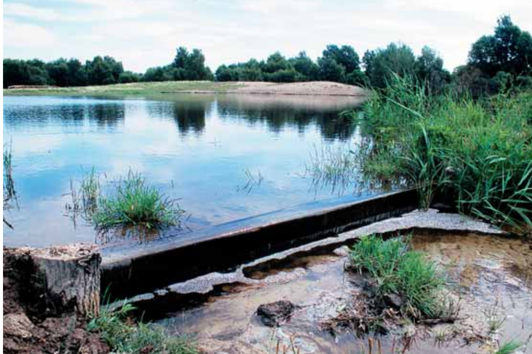
Principen för ett dämme är att låta vattnet rinna sakta genom området. Helst ska uppehållstiden vara flera dygn. Kalmar Dämme har anordningar för detta.
