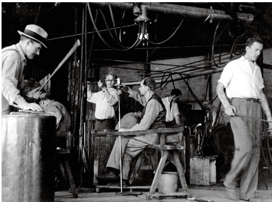
Framgångens tid. Full fart i glashyttan på Ruda glasbruk. Glasmassan färgades med tungmetaller som så småningom hamnade i marken.
