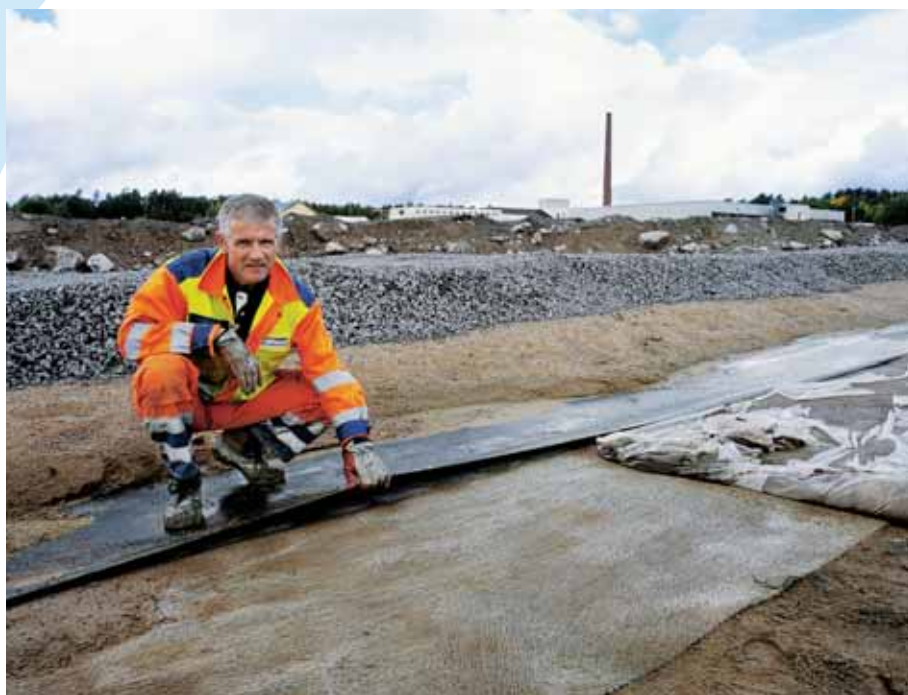
Vid saneringen av Örserumsviken i Västervik täcktes de uppmuddrade massorna med PCB och kvicksilver med skyddsskikt av bland annat kraftig plastfilm, bentonitlera, sand och makadam. Håkan Larsson, platschef vid Vägverket Produktion, visar uppbyggnaden i olika lager.
