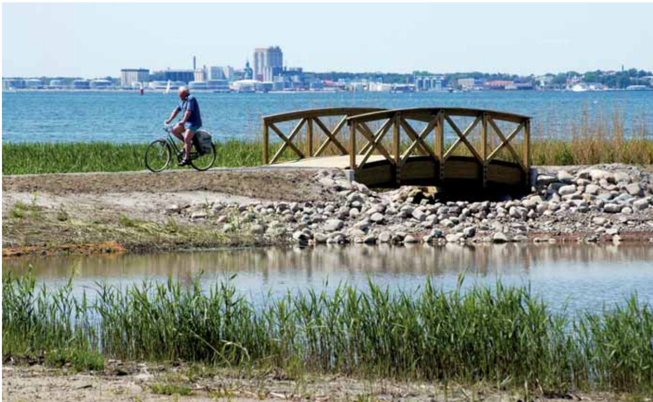
I samband med ombyggnaden i Färjestaden har det anlagts ett stort dämme vid den gamla strandängen norr om hamnen. Dämmet har också fått strövstigar och broar och ska fånga upp dagvattnet från samhället.
