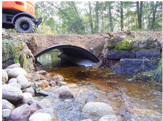
Restaurerad vägtrumma i Stora Hammarsjöns utlopp. Foto Jens Nilsson.
