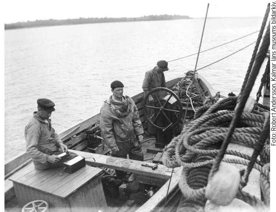
Dykarbeten vid Elefantens vrakplats i Kläckebergaviken under 1930-talet.
