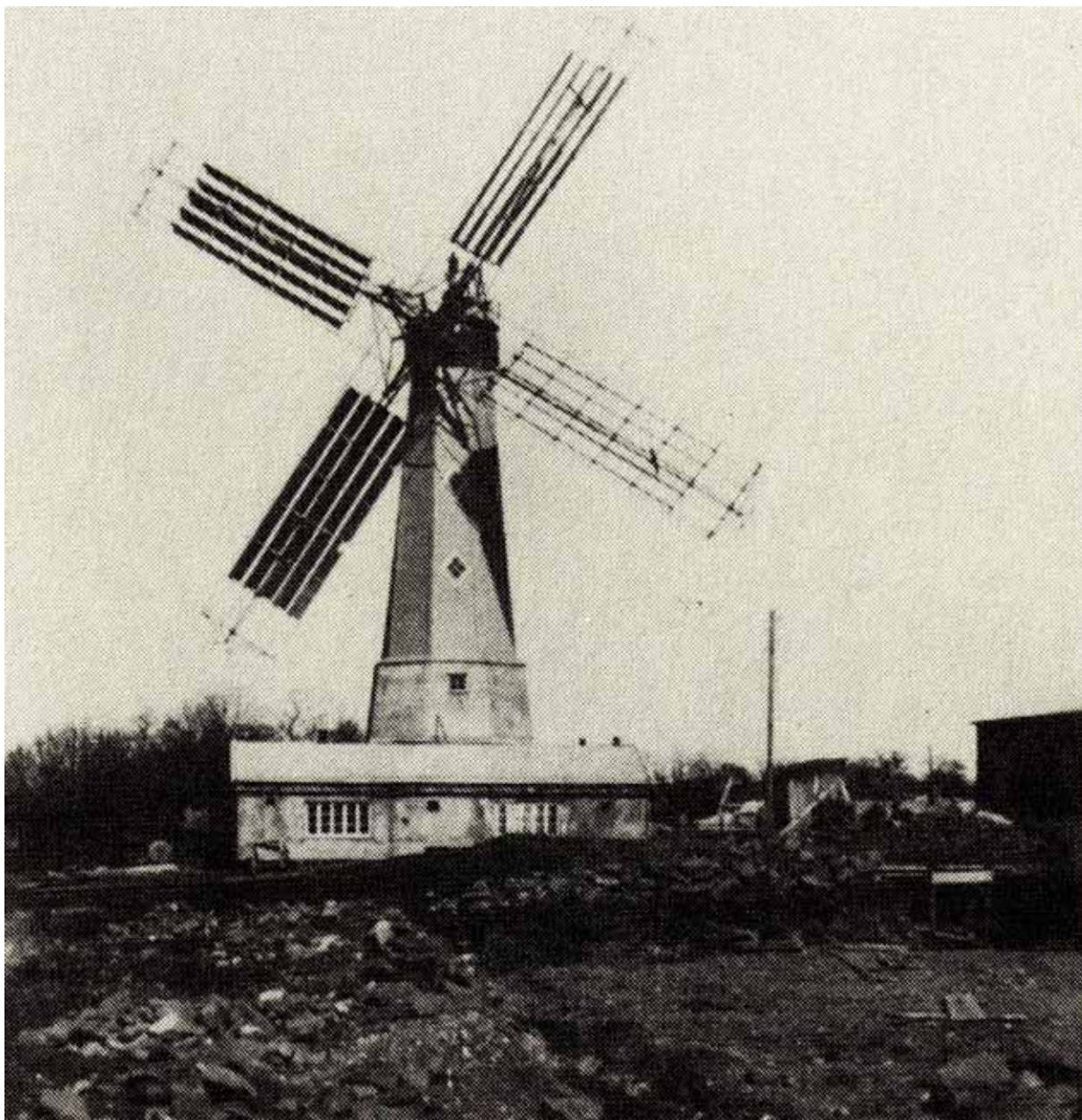
Elektricitetsverket på Ekerums gård startades 1914. Anläggningen var ca 20 m hög, och varje vinge hade en längd på 12 m.
