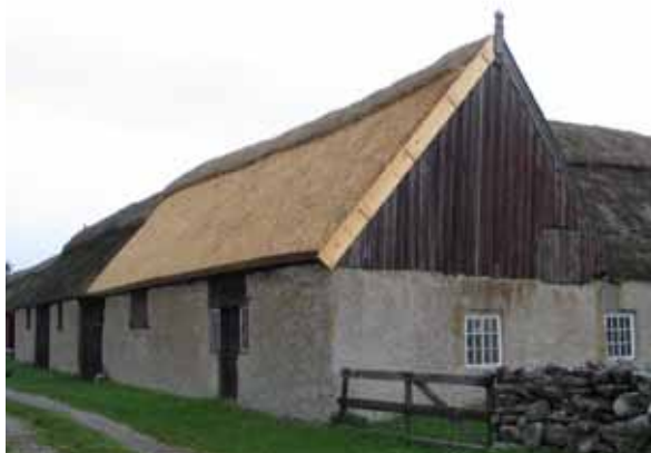
Nylagt vasstak i Södra Sandby, södra Öland. Foto Magnus Johansson, Kalmar läns museum.
