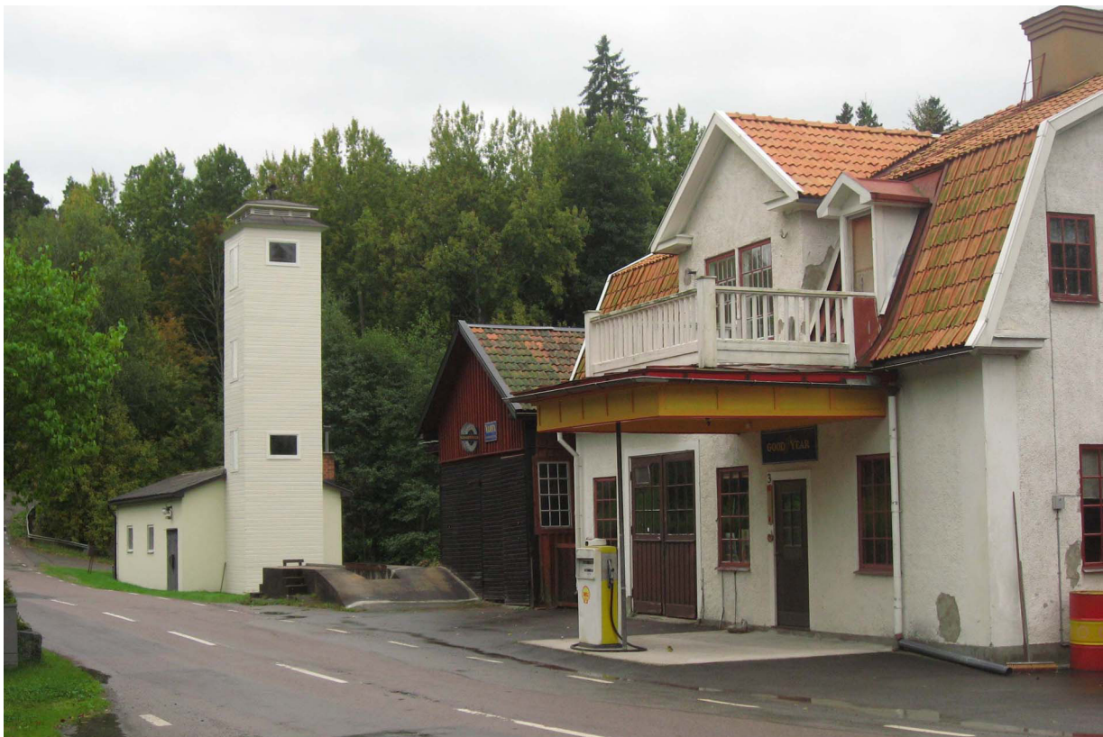
Macken och brandstationen i Mörtfors. En av många tätorter som växte fram under 1800-talet. Foto Per Lindegård.
