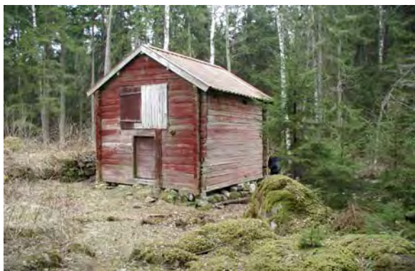
Klobo kvarn. Liten välbevarad knuttimrad hjulkvarn, enligt uppgift från 1700-talet. Dammen finns inte kvar vilket gör upplevelsen av kvarnmiljön "fattigare". Foto: Lennart Johansson
