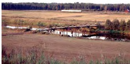
Spännverksbro i trä över Emån söder om Högsby (enskild väg), byggd i en ålderdomlig teknik. Konstruktionens ursprungliga karaktär är välbevarad. Foto: Coco Dederling
