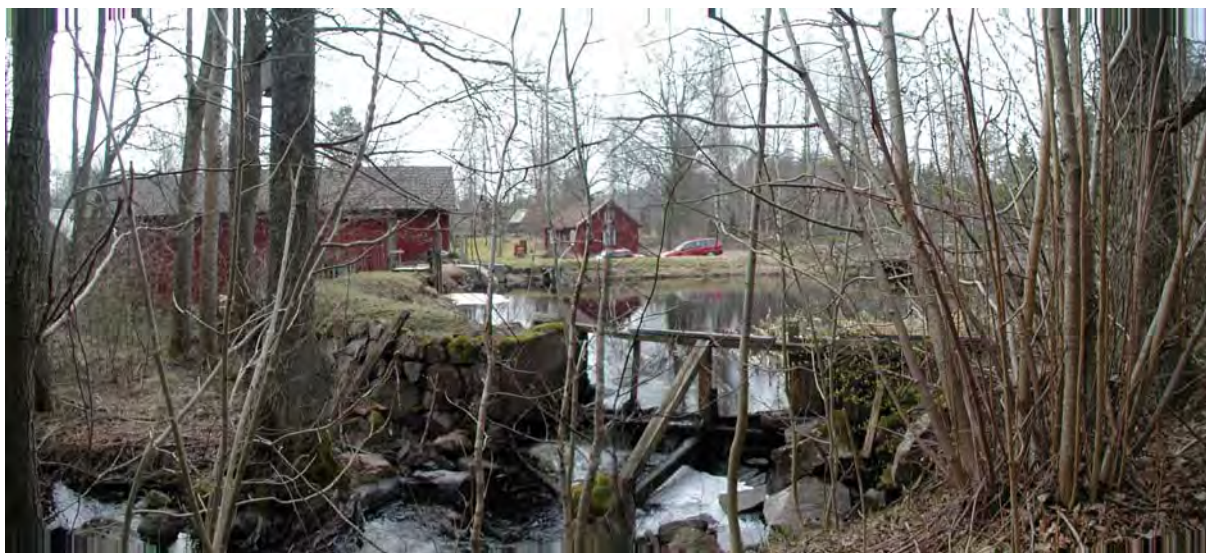
Kronobo kvarn. Dammen utgör ett vandringshinder. Fiskvägen föreslås anläggas genom ett av dammens tre utskov, det närmast i bild. Ingreppet i dammen blir förhållandevis litet på kulturmiljön som helhet, jämfört med ett omlöp. Omlöp är här ej att föredra. Norr om ån, till höger i bild, ligger ett fornlämningsområde med bl a slagg efter en masugn. Söder om ån, till vänster i bild är kvarn- och gårdsmiljön, genom vilken ett omlöp inte heller är att föredra.
