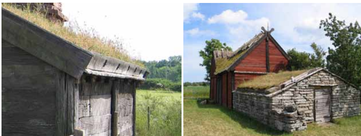
Många Ölandshus kan visa upp speciella, ofta ålderdomliga, detaljer. Här ett par illustrationer från Himmelsberga museigård. T.v.: Takfoten på torvtaken täcks ibland med kalkstensflisor. T.h.: Skiftesverksbyggnaderna har ibland s.k. högsulor, stolpar som håller upp takåsen och vindskivorna kröns ofta av s.k. takkråkor.
