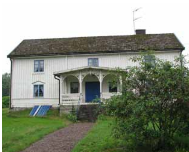
Gavelformade överstycken på fönstren, avvikande, ofta liggande, panel under bottenvåningens fönster och friser av bågformer under fönstren och takfoten kännetecknar ”Torsåspanelen” som finns i den sydligaste delen av Möre, jmf karta s. 11.
