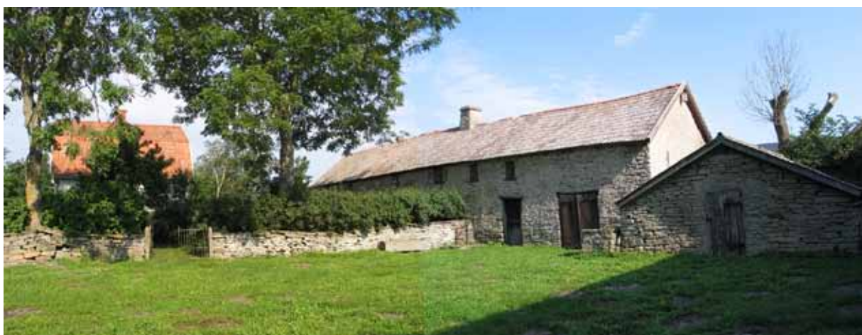
Den frekventa användningen av kalksten för olika typer av byggnadsändamål är ett av de tydligaste särdragen i den öländska byggnadskulturen. Lunda i Kastlösa.
