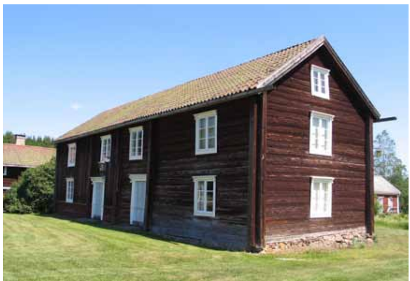
I den norra delen av regionen, liksom i angränsande delar av Höglandsdelen, kan man sällsynt påträffa s.k. tvillingstugor, en hustyp som utgörs av två sammanbyggda, spegelvända enkelstugor. Denna hustyp betraktas som ålderdomlig, typisk för trakterna på/i anslutning till småländska höglandet och som ett uttryck för 1700-talets hemmansklyvningar. Fröreda Storegård.
