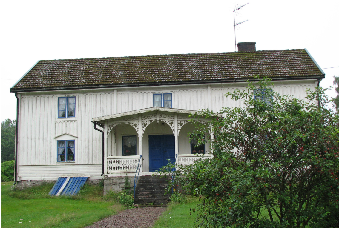
I de sydligaste delarna av ”Mellersta skogsbygderna” är den s.k. ”Torsåspanelen” vanlig, jmf kartan sid. 11.
