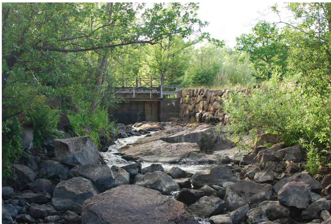
Figur 41. Foto på Kvillen vid Kvarnholmen, nedströms fördämningen. Foto: P. Johansson.
