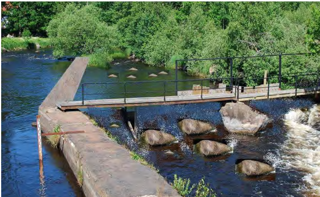
Figur 40. Retuscherad skiss på förslag på fiskväg vid åtgärdslokal 3E. Dammvallen förlängs ut till holmen och hindret rivs ut, i ovankant skapas en naturlig strömnacke och denna nivå reglerar vilket flöde som skall rinna i strömfåran.
