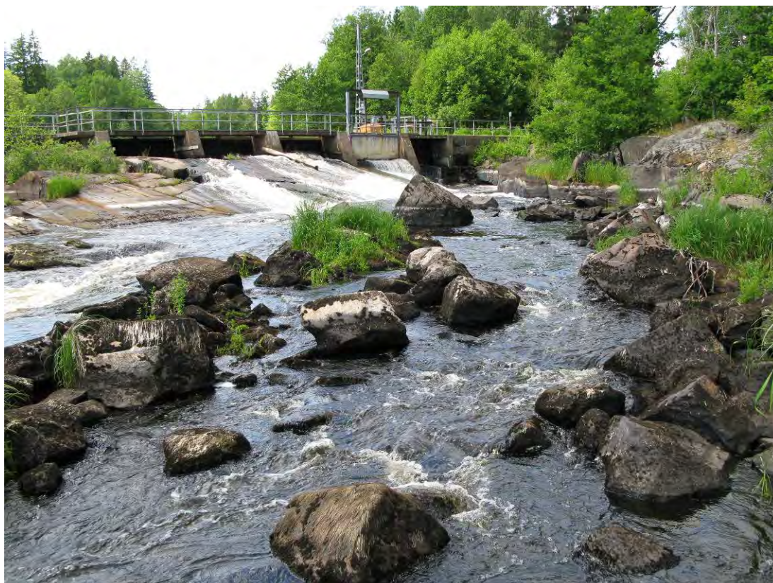
Figur 46. Vy över potentiellt lek område i torråran nedströms Finsjö övre kraftverk. Omlöpets mynnar till höger om utskovet längst till höger i bilden. Foto: T. Nydén.
