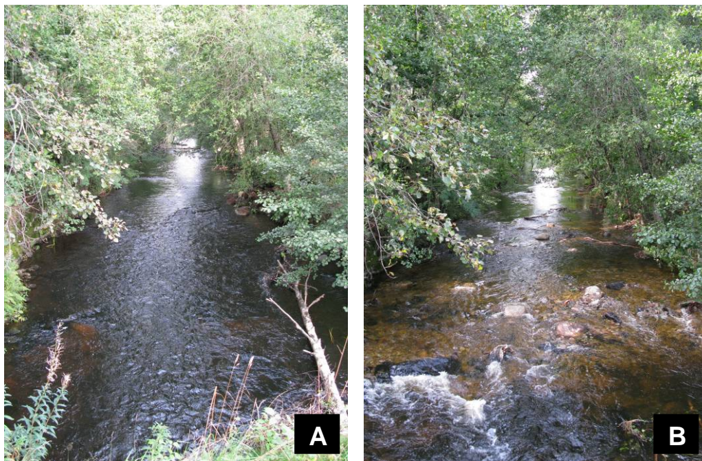
Figur 56. Exempel på genomförd biotopvård i en sänkt kanal utförd med en bandgående grävmaskin. Bild A: före åtgärd, bild B: block och sten har lagts ut, därefter dressas botten med lämpligt lekgrus. Målet är att få ett så naturligt utseende som möjligt. (den stora döda vedbiten flyttades nedströms då den låg för nära vägtrumman) Foto: T. Nydén
