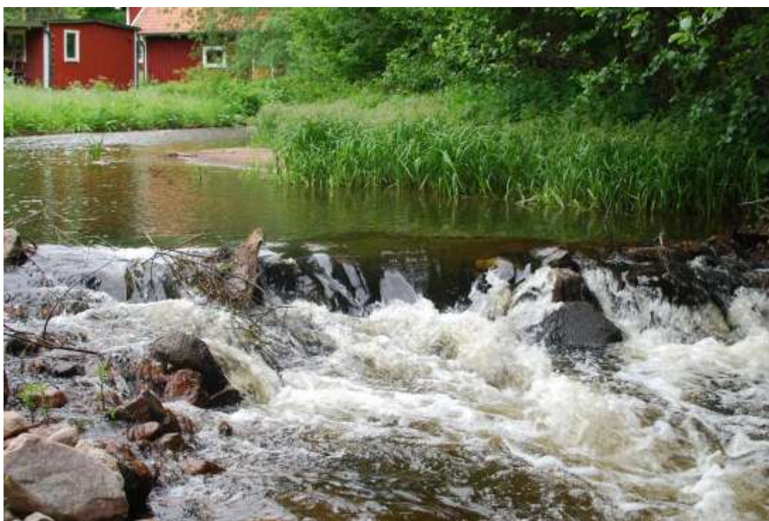
Figur 28. Lokal 4 A (VH1) i Loftaån. En mindre fördämning bestående av upplagda block och stenar tvärs över ån. Foto: P. Johansson.
