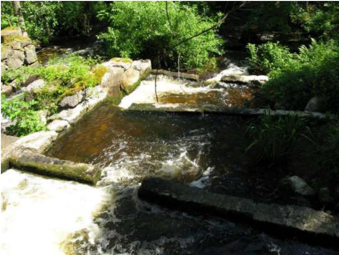
Figur 40. Den befintliga, gjutna bassängtrappan vid Rabo. Foto: T. Nydén.
