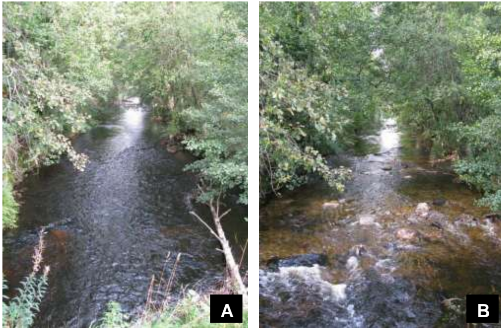
Figur 44. Exempel på genomförd biotopvård i en sänkt kanal utförd med en bandgående grävmaskin. Bild A: före åtgärd, bild B: block och sten har lagts ut, därefter dressas botten med lämpligt lekgrus. Målet är att få ett så naturligt utseende som möjligt. (den stora döda vedbiten flyttades nedströms då den låg för nära vägtrumman) Foto: T.Nydén
