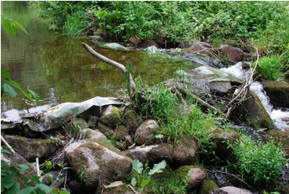
Figur 31. Uppbyggd stendamm tätad med dukar vid Sågaretorp utgör en svårpasserbar passage. Foto: P. Johansson.
