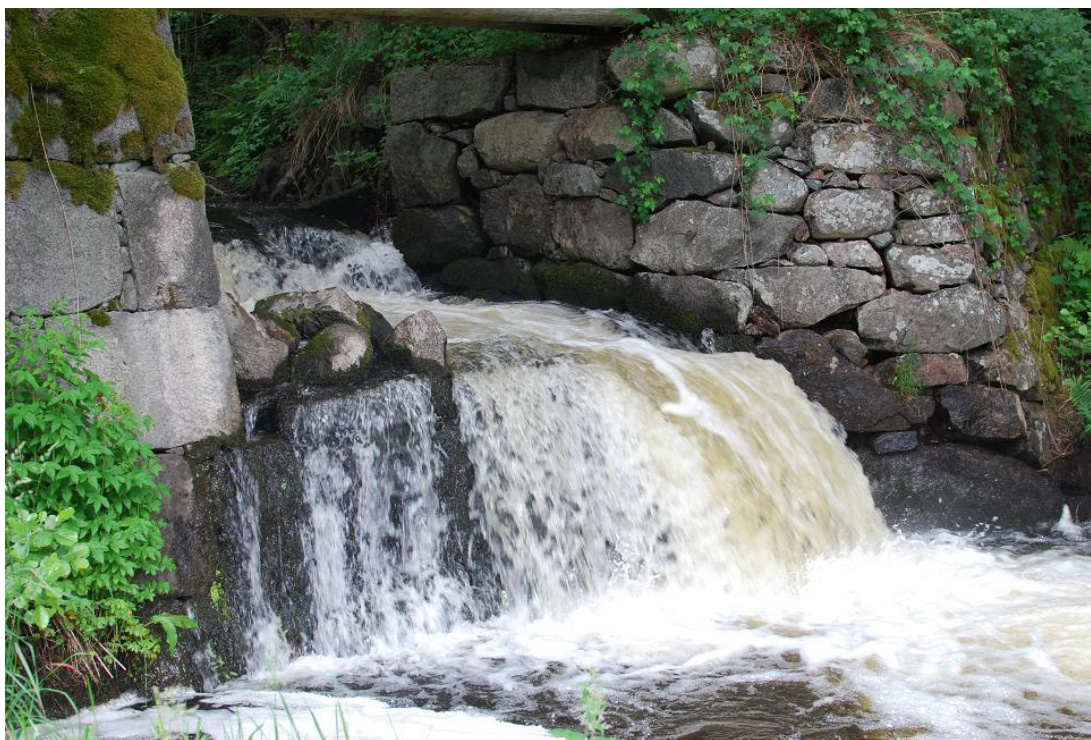
Figur 33. Äldre stendamm som utgör ett svårpasserbart vandringshinder för havsöring och definitivt för andra arter. Foto: P. Johansson.
