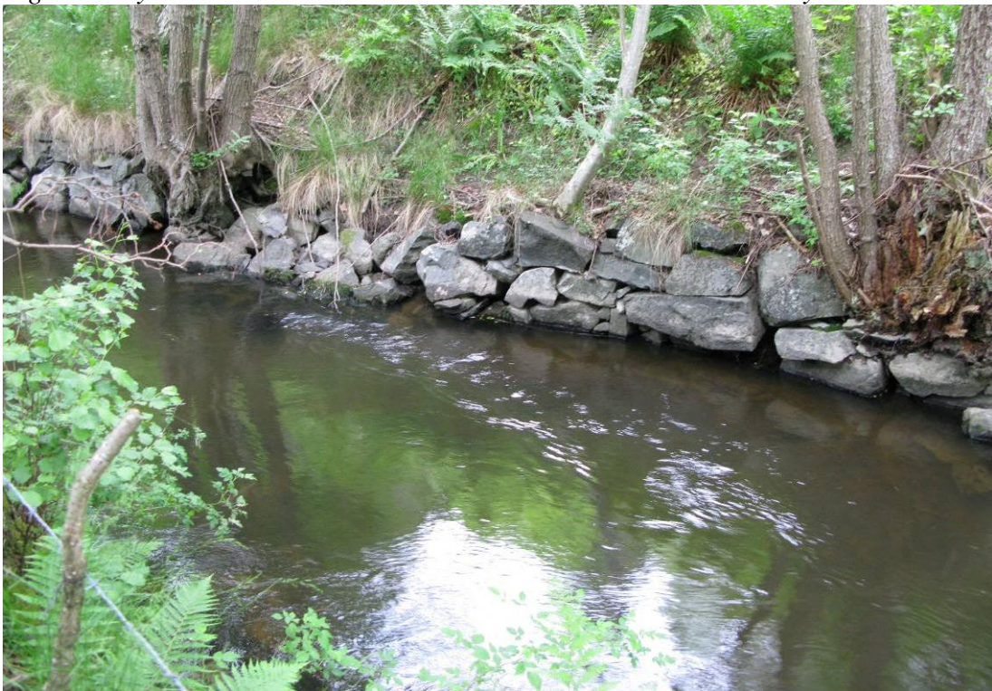
Figur 20. Längs övre delen av åtgärdslokalen är kanterna stensatta. Foto: T. Nydén.
