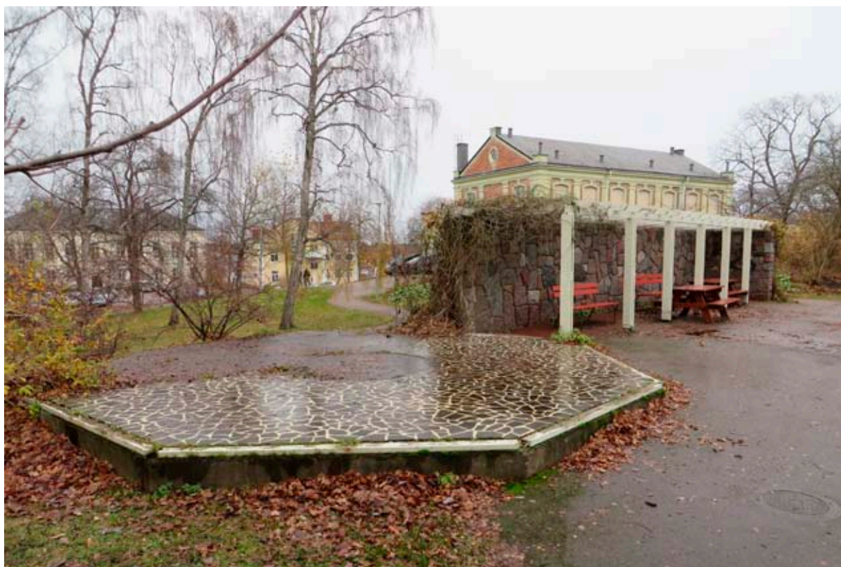
En servering i stadsparken är efterfrågad av oskarshamnsborna. Av det tidigare kaféet finns endast bottenplattan kvar, liksom uteserveringens mur och pergola.
