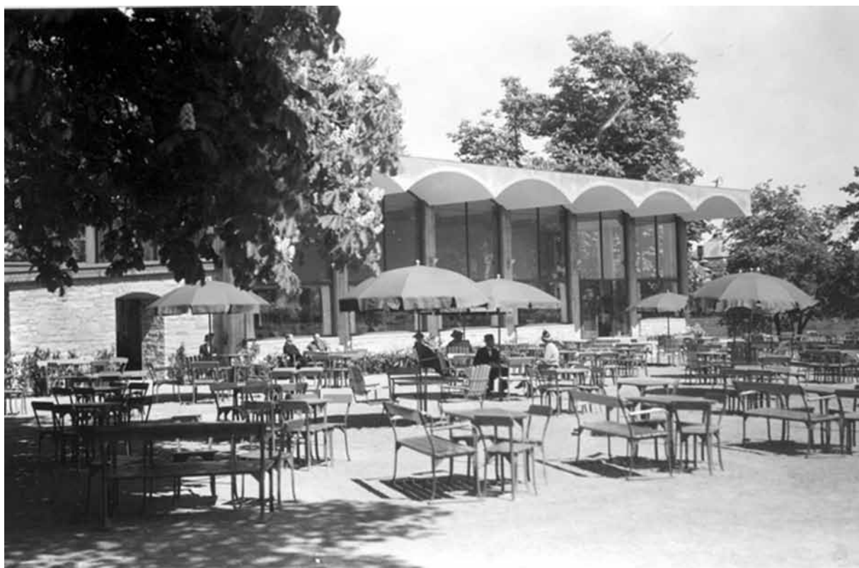
Den nybyggda restaurang Byttan med terrassen mot söder 1940. Fotograf: Walter Olsson. Källa: Kalmar läns museum
