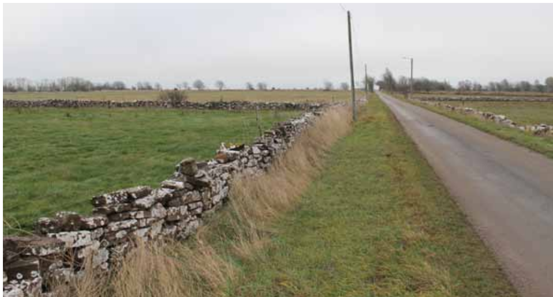
Gärdesmur utmed vägen i Kärra.
