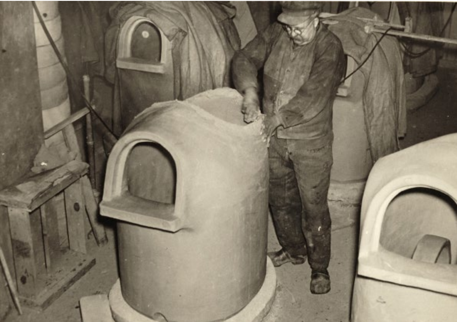
Tillverkning av deglar till glasugnen. Foto: Pukebergs bruksarkiv/Nybro kommunarkiv
