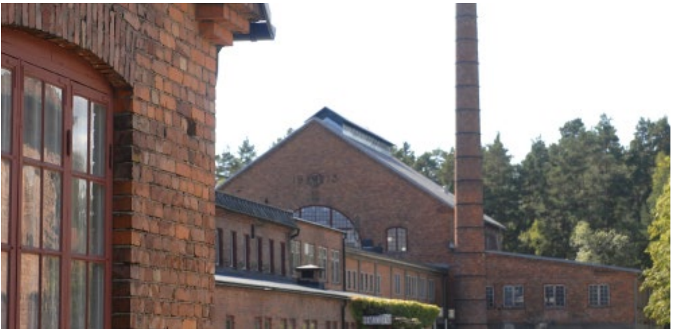
Det långa glasbrukskomplexet sett från nordost. Foto: Thomas Lissing
